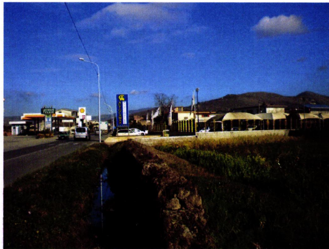
Fig. 5. Ex SS 162 in corrispondenza della nuova intersezione a T.
