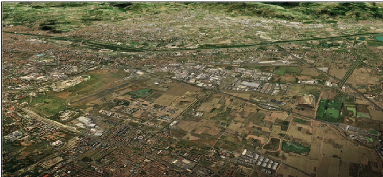
Figura 5: Vista dell'area di intervento in direzione nord-ovest
