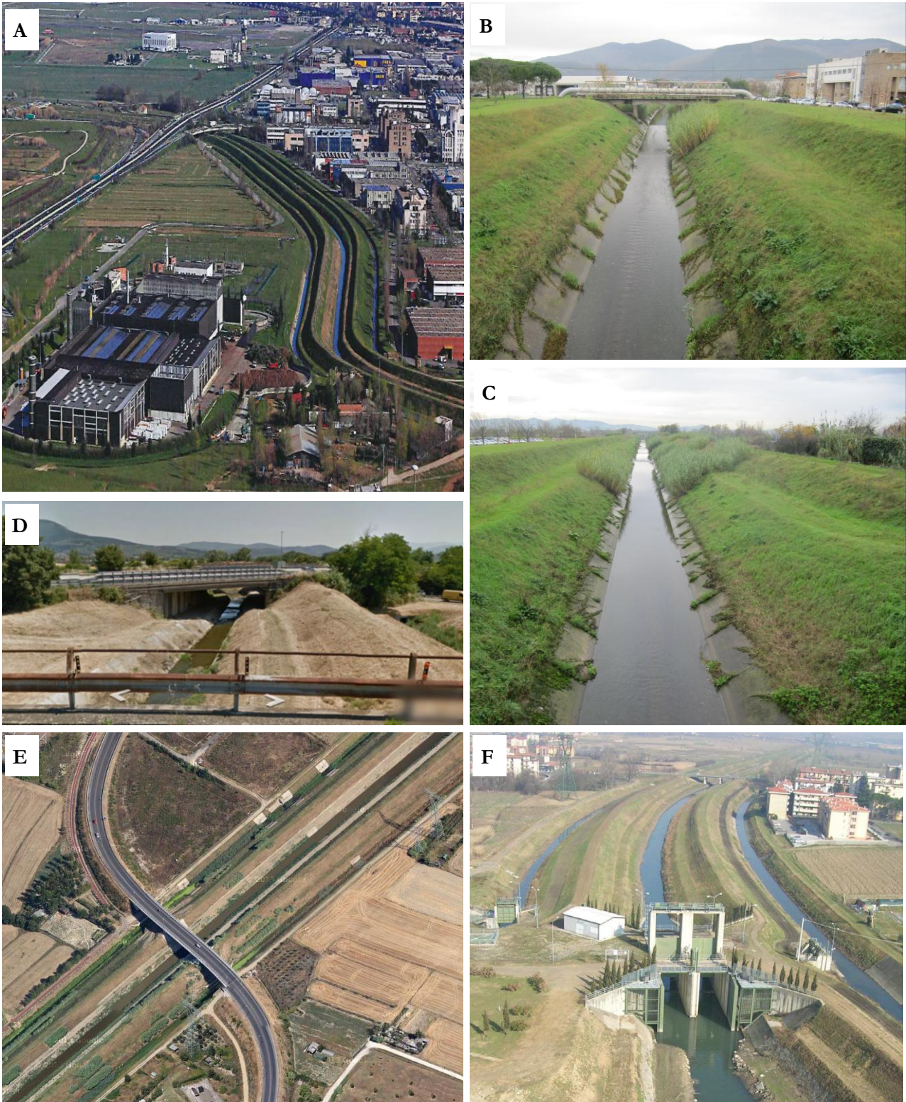
Figura 32. Fosso Reale (acque alte) e, a fianco, i Colatori destro e sinistro (acque basse) del Fosso reale in corrispondenza di diversi ambiti della piana: a) zona Osmannoro e impianto di compostaggio; b) e c) zona Polo scientifico e tecnologico di Sesto Fiorentino; d) passaggio autostradale A11; e) località San Piero a Ponti; f) paratoia presso l'immissione nel Fiume Bisenzio
