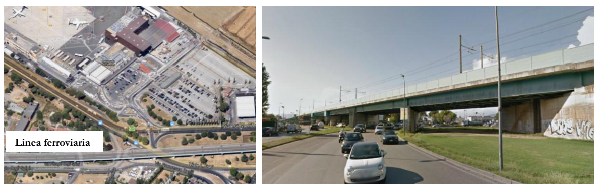
Figura 9. L'attuale linea ferroviaria presente nei pressi dell'aeroporto
