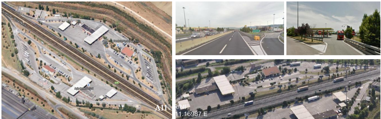
Figura 17. Aree di servizio poste sulla A11 Firenze-Mare
