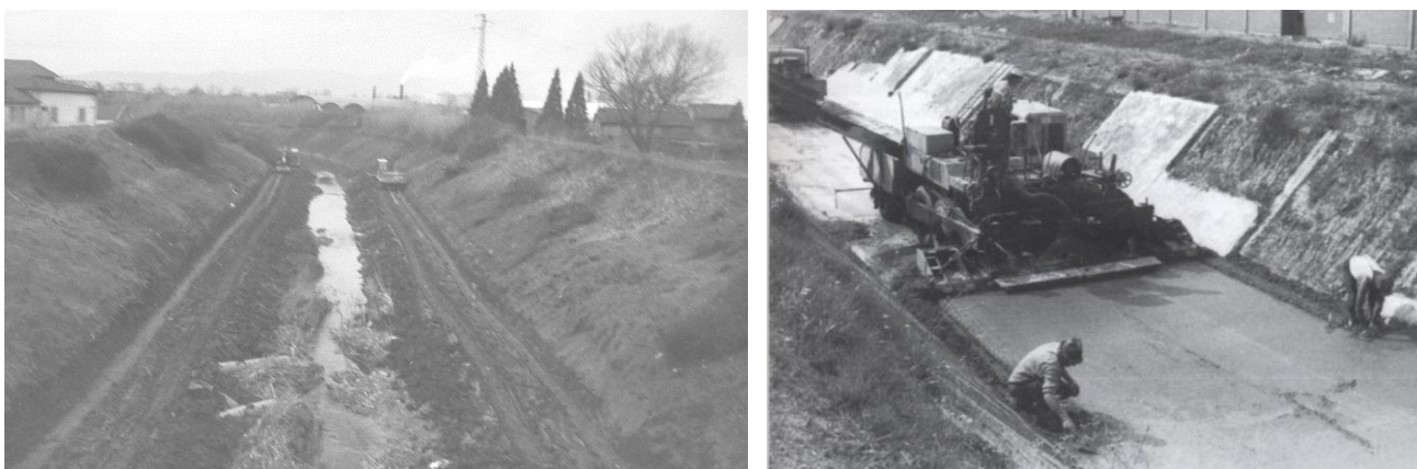
Figura 29. Lavori di ampliamento del Fosso Reale (a sinistra) e adeguamento della sezione idraulica del Canale Nuovo Garille alla fine degli anni Settanta (a destra)
