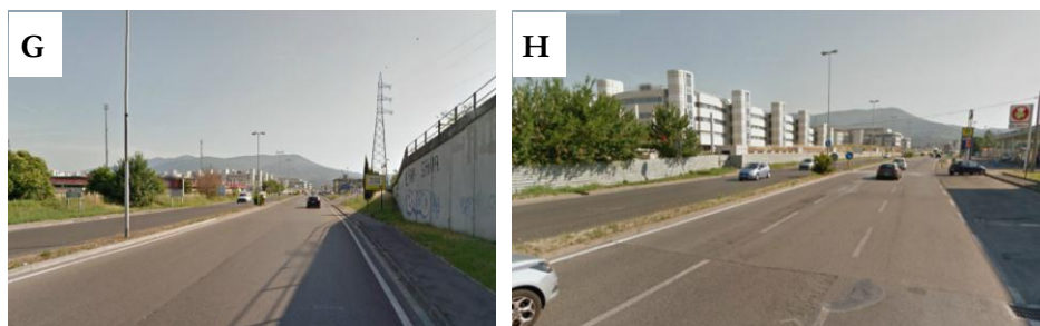
Figura 7. La viabilità urbana nell'area circostante l'ingresso all'aeroporto di Firenze: a) e b) Via Pratese; c) e d) Via Pistoiese; e) e f) Viale Guidoni; g) e h) Viale XI Agosto
