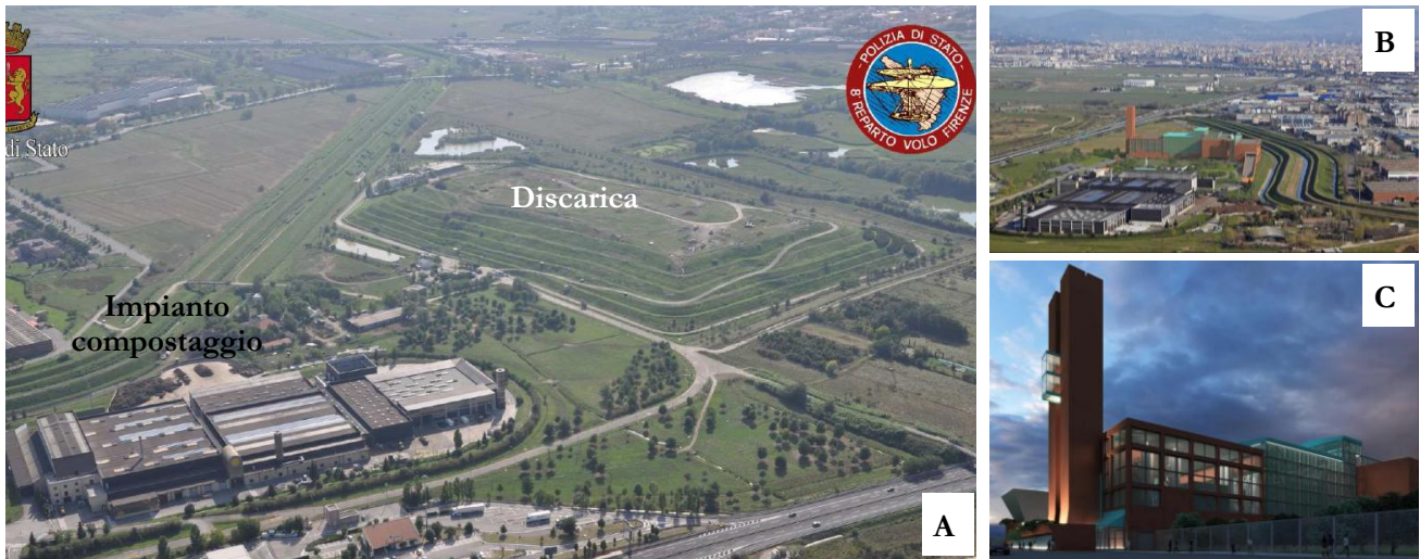
Figura 16. Polo di trattamento rifiuti: a) discarica di Case Passerini e impianto di compostaggio; b) e c) fotosimulazioni relative al progetto del futuro impianto di termovalorizzazione
