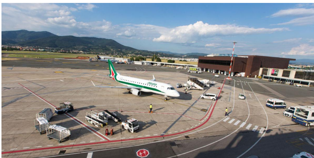
Figura 56. Piazzale Apron 100 antistante il Terminal
