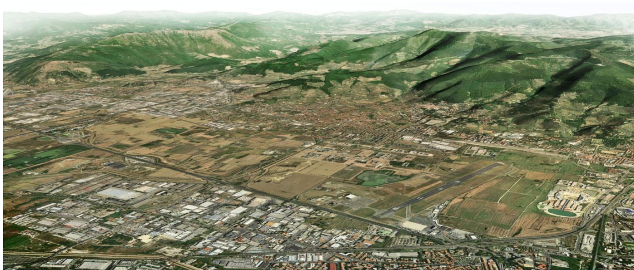
Figura 3. Vista dell'area di intervento in direzione nord-ovest
