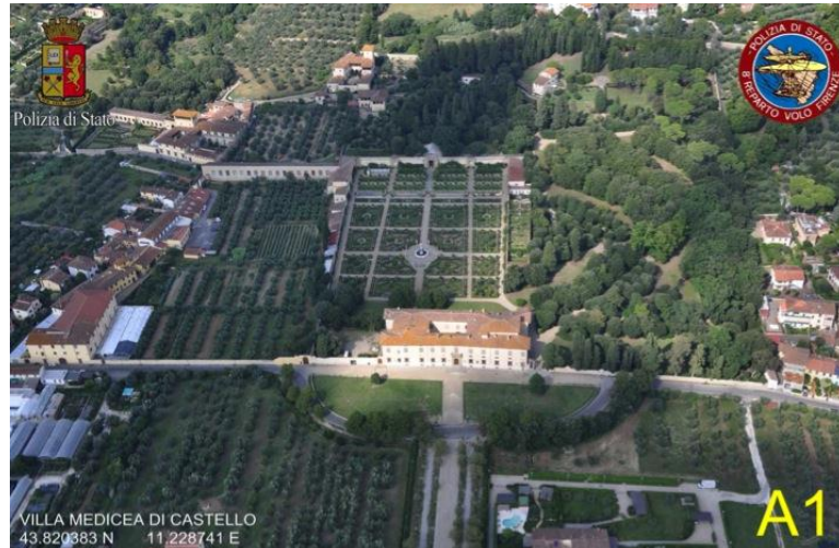
Figura 47 – Foto aerea del sito della villa di Castello
