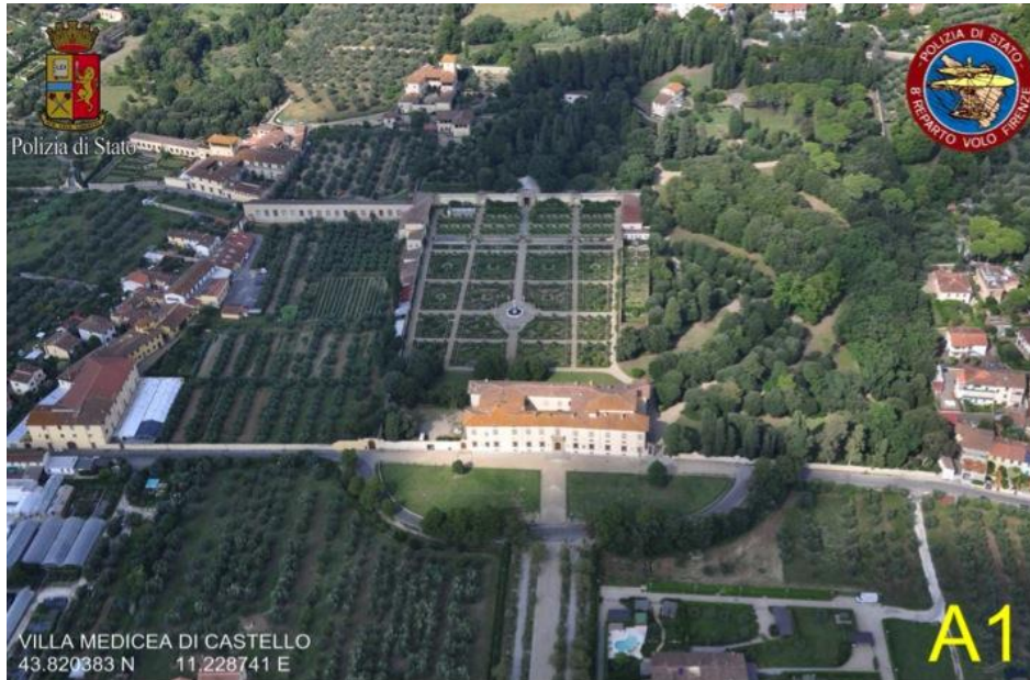
Figura 47 – Foto aerea del sito della villa di Castello
