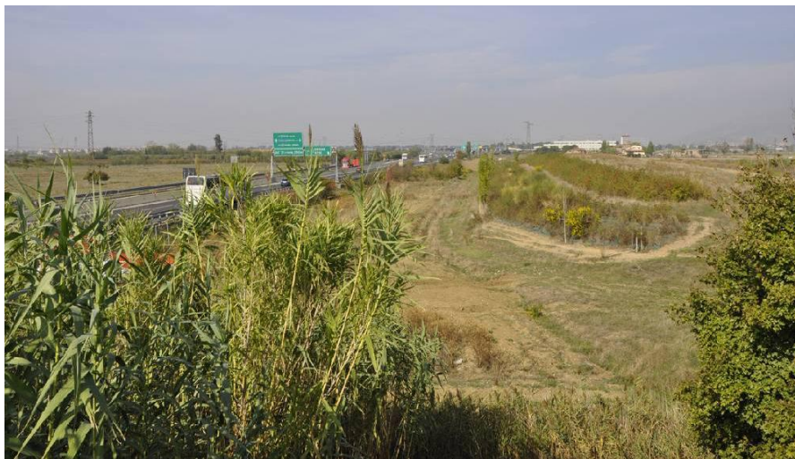
Fig. 40 Il raccordo autostradale della A11
