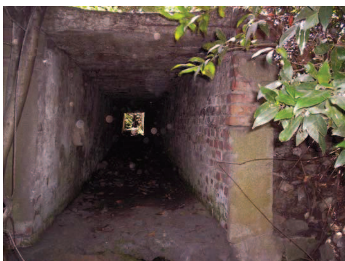
Fig. 8 – Vista della sezione scatolare del 1° tratto del canale dell'Aeroporto
