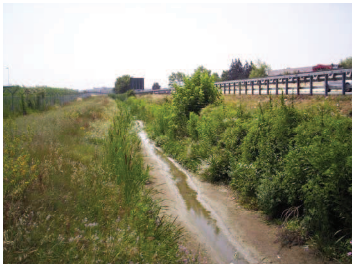
Fig. 7 – Vista del canale dell'Aeroporto
