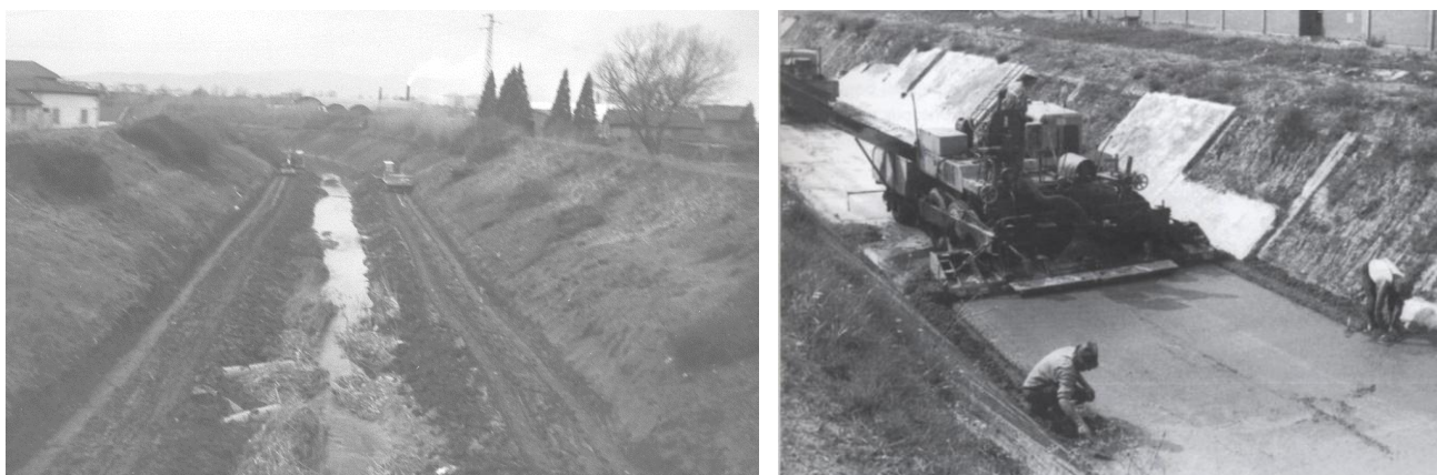
Figura 29. Lavori di ampliamento del Fosso Reale (a sinistra) e adeguamento della sezione idraulica del Canale Nuovo Garille alla fine degli anni Settanta (a destra)
