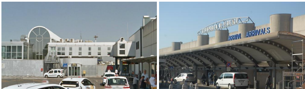
Figura 61. Edificio Partenze (sulla sinistra), con percorso di collegamento all'edificio arrivi (sulla destra)
