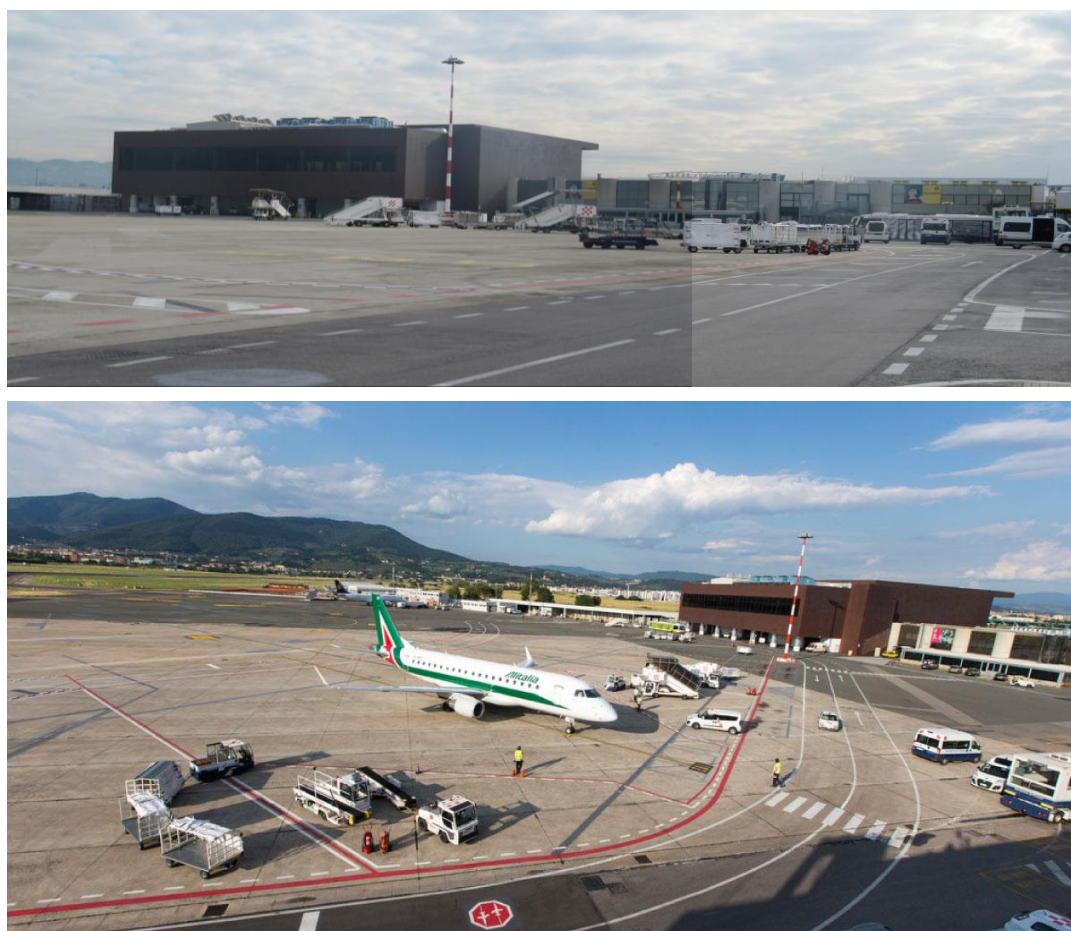
Figura 56. Piazzale Apron 100 antistante il Terminal
