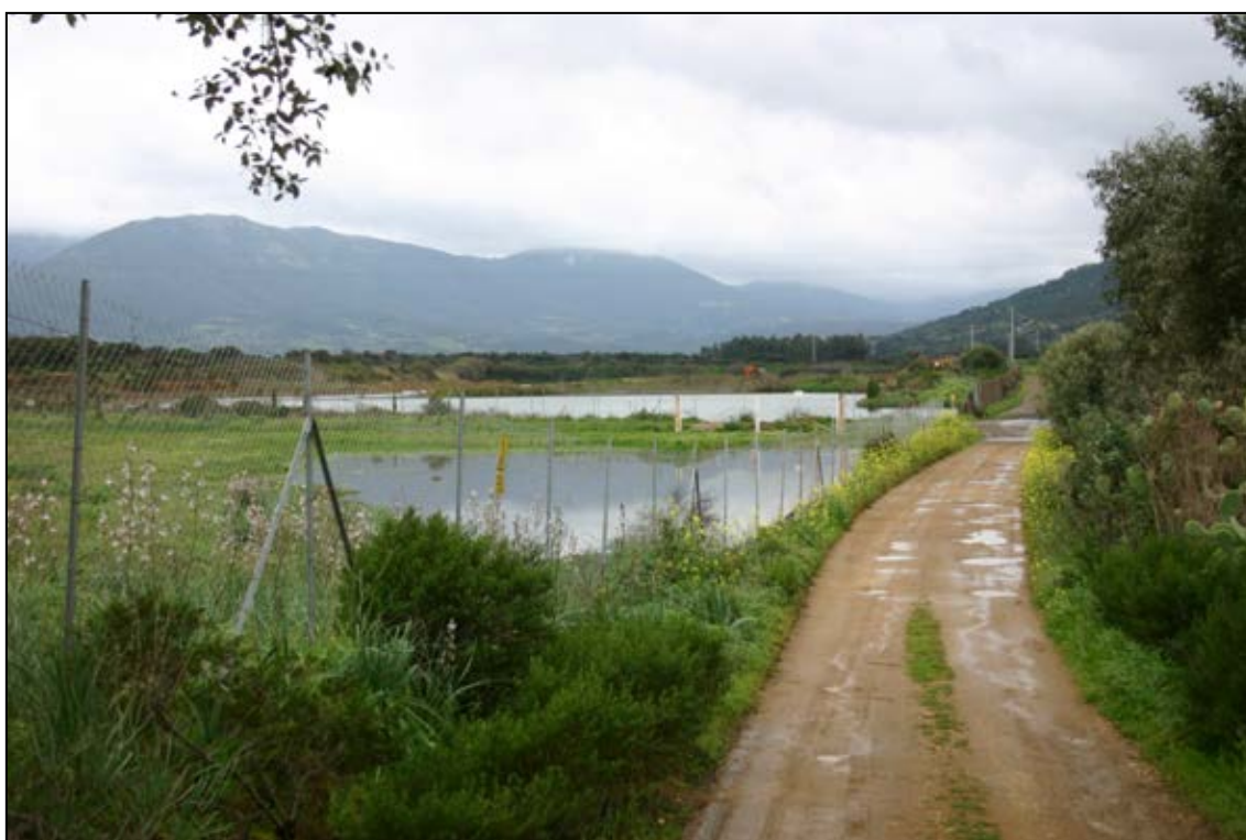
Figura 31: Laghetto cava Calcestruzzi SpA tracimato
