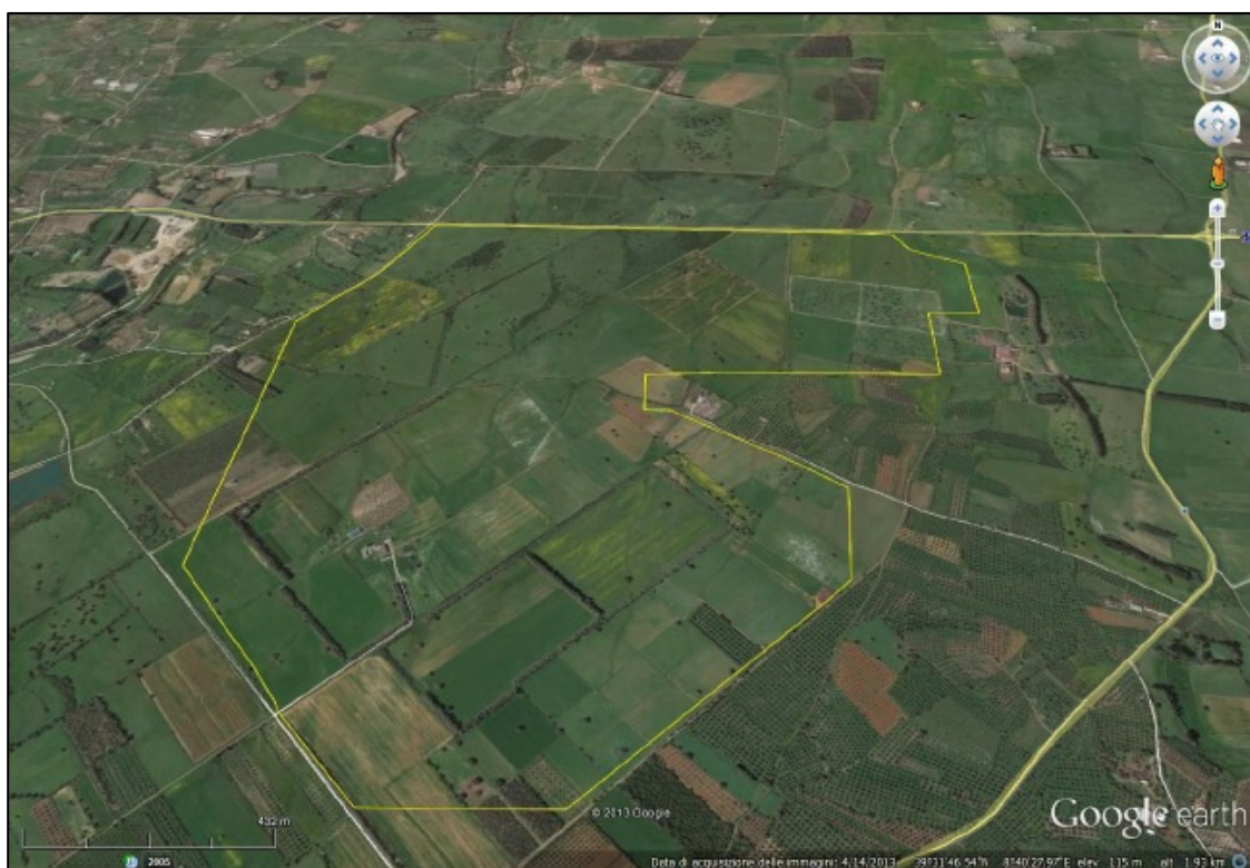
Figura 45: Immagine scattata con Google Earth in cui si vede la zona di sedime dell'impianto delimitata dalla linea gialla
