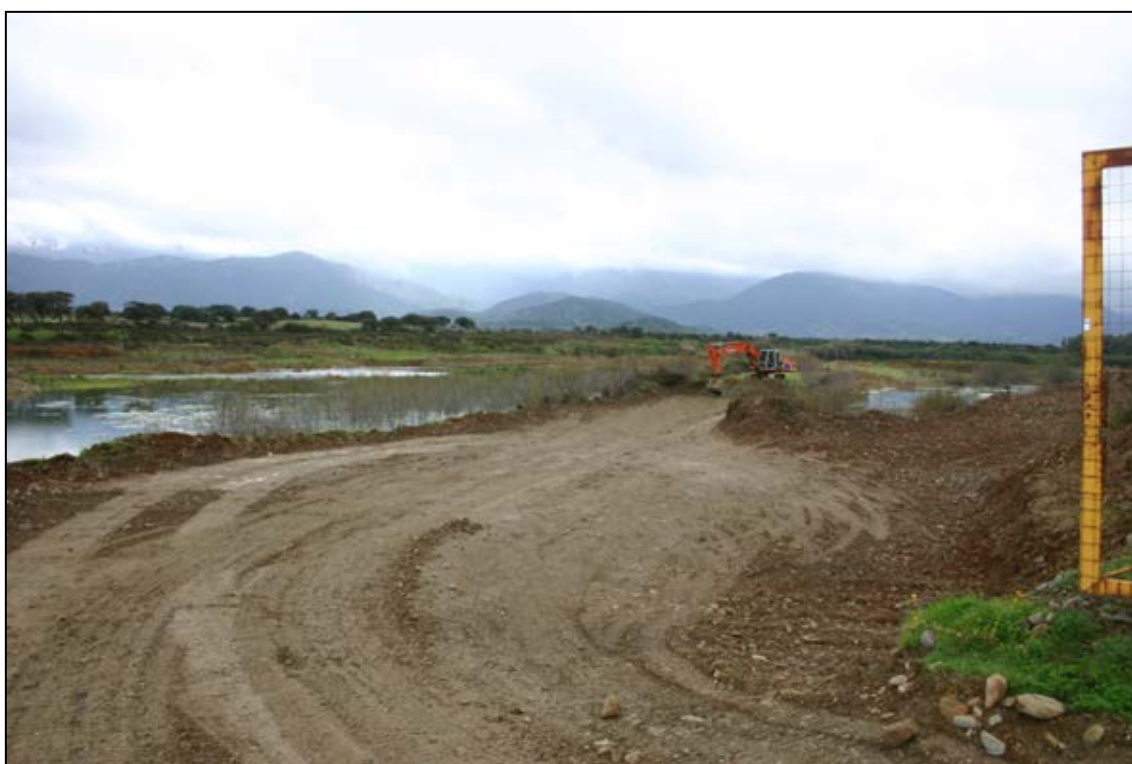
Figura 42: Area limitrofa all'area impianto
