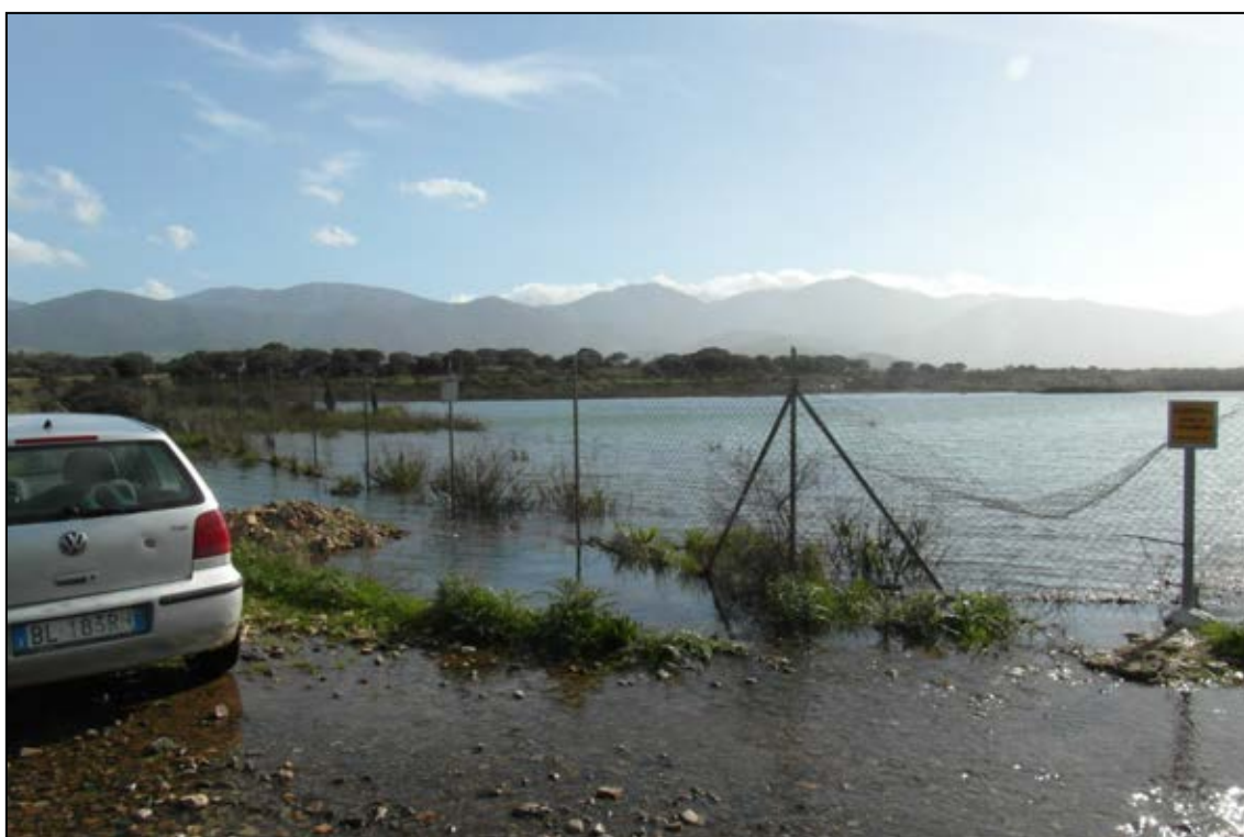
Figura 29: Laghetto cava Calcestruzzi SpA tracimato
