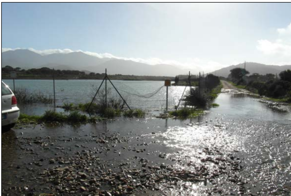
Figura 28: Laghetto cava Calcestruzzi SpA tracimato
