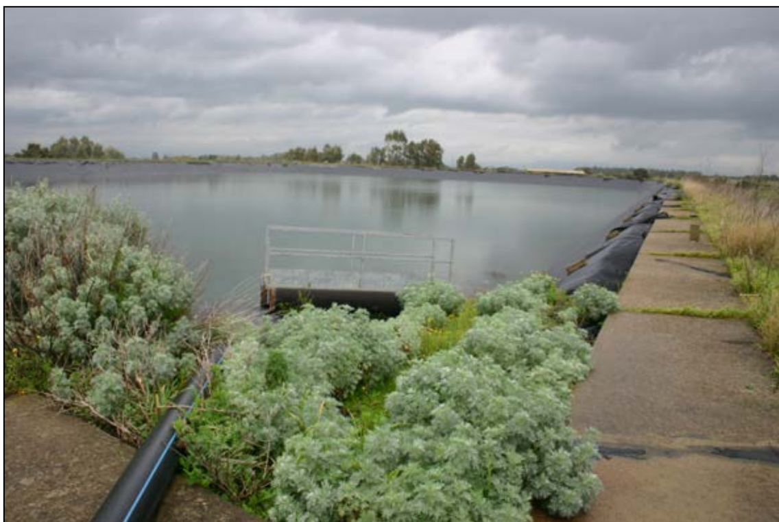
Figura 40: Area limitrofa all'area impianto
