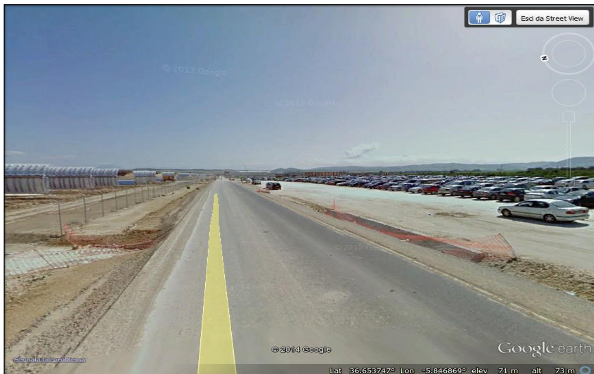
Figura 14: Impianto solare termodinamico in costruzione di San José del Valle
