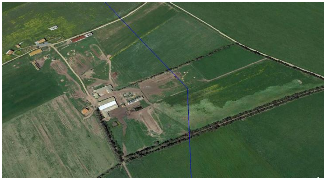
Figura n. 6: Grave forma di costipamento dell'orizzonte superficiale area impianto(ortofoto 2014)
