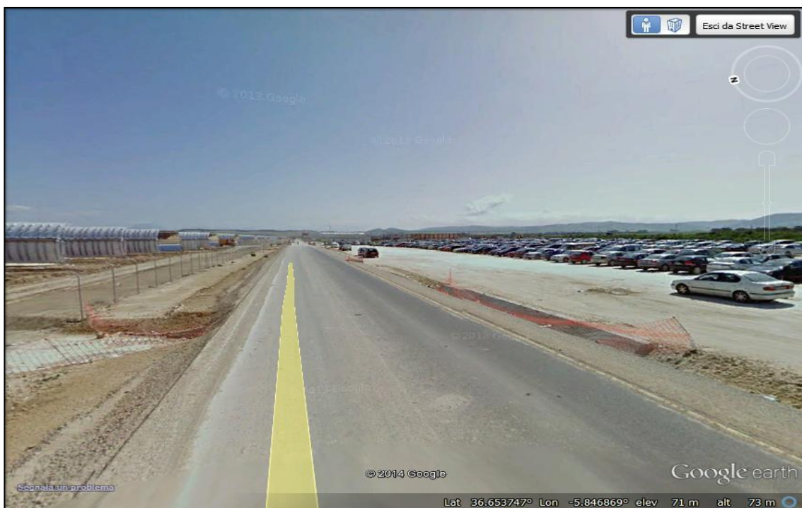
Impianto solare termodinamico in costruzione di san José del Valle
