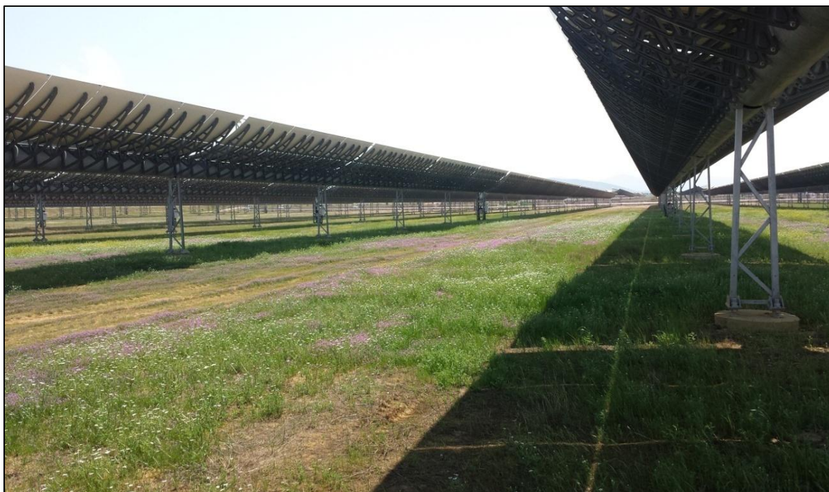
Attività agropastorale all'interno di una centrale solare (impianto Extresol 1-2-3 – Spagna)
