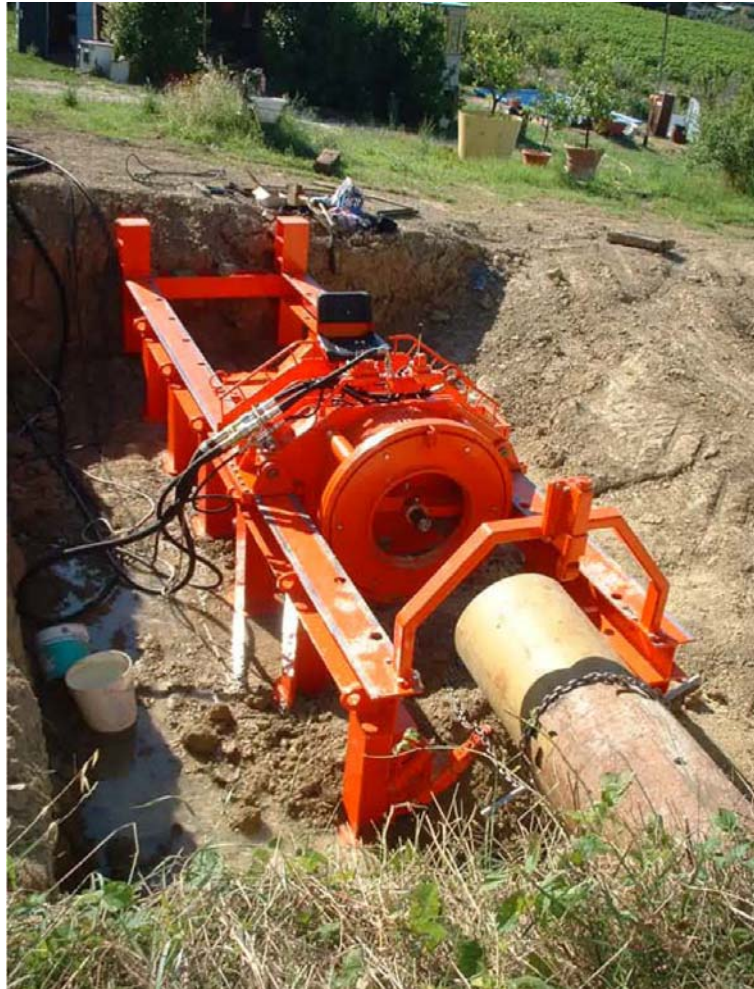
Figura 8.h: Esempio di Trivella Spingitubo
