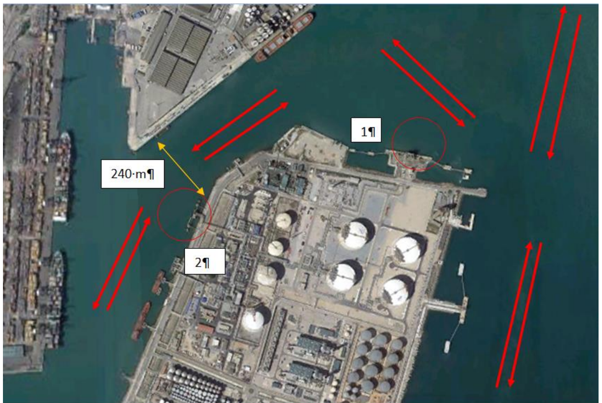
Figura 3.c: Terminale GNL di Barcellona, Dettaglio degli Accosti
