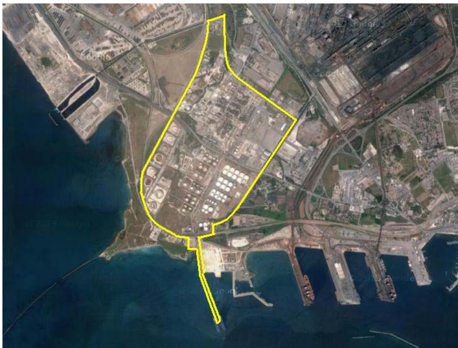
Figura 3.B- Perimetro della Raffineria eni di Taranto (in giallo)
