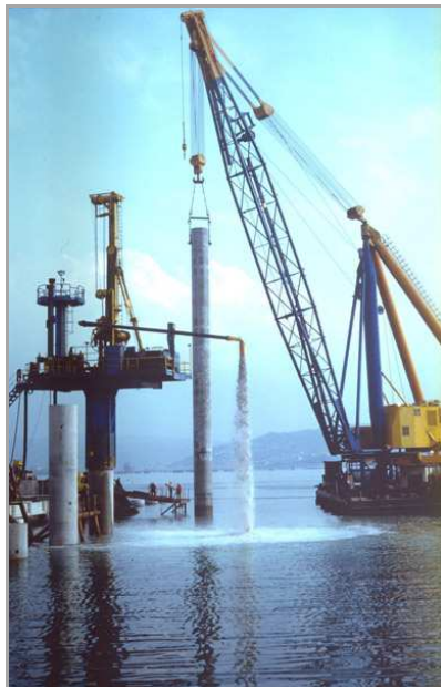
Figura 4 Immagini della fase di realizzazione del completamento del Molo VII (anni '80)
