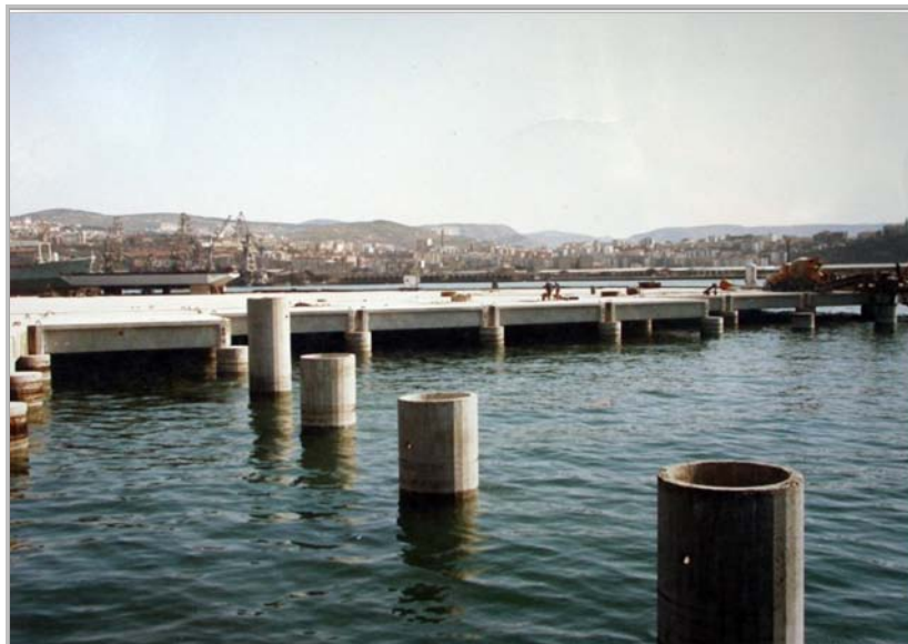
Figura 4 Banchina realizzata mediante piastra su pali
