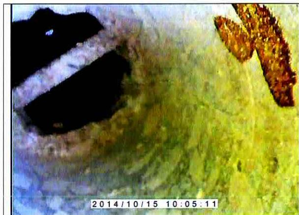
Calcestruzzo integro. Non sono presenti evidenti segni di ammaloramento. Fondo foro presenza di barre d'armatura di 14 mm. Spessore piastra 260mm.
