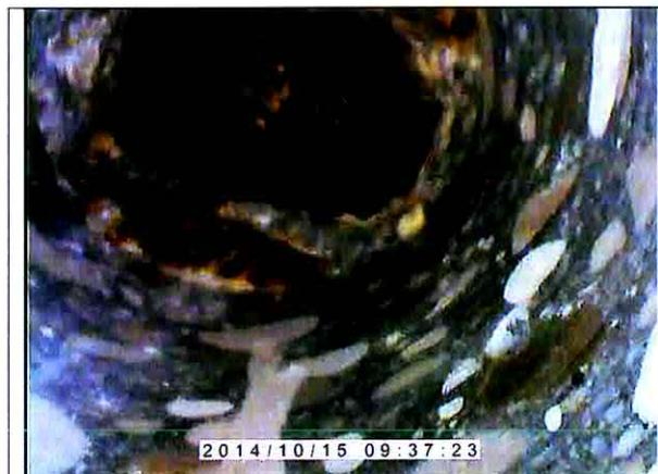
Calcestruzzo integro. Non sono presenti evidenti segni di ammaloramento. Fondo foro presenza di barre d'armatura diam. 14 mm. Spessore piastra 260 mm.
