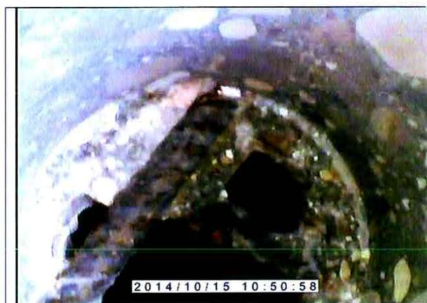
Calcestruzzo integro. Non sono presenti evidenti segni di ammaloramento del calcestruzzo. Fondo foro presenza di barre d'armatura di 14 mm. Spessore piastra 280 mm.
