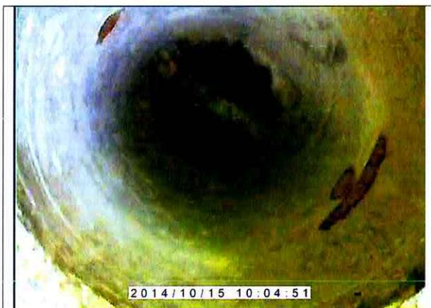
Calcestruzzo integro. Non sono presenti evidenti segni di ammaloramento. Presenza di barre d'armatura diam. 14 mm a 60 mm dal top.
