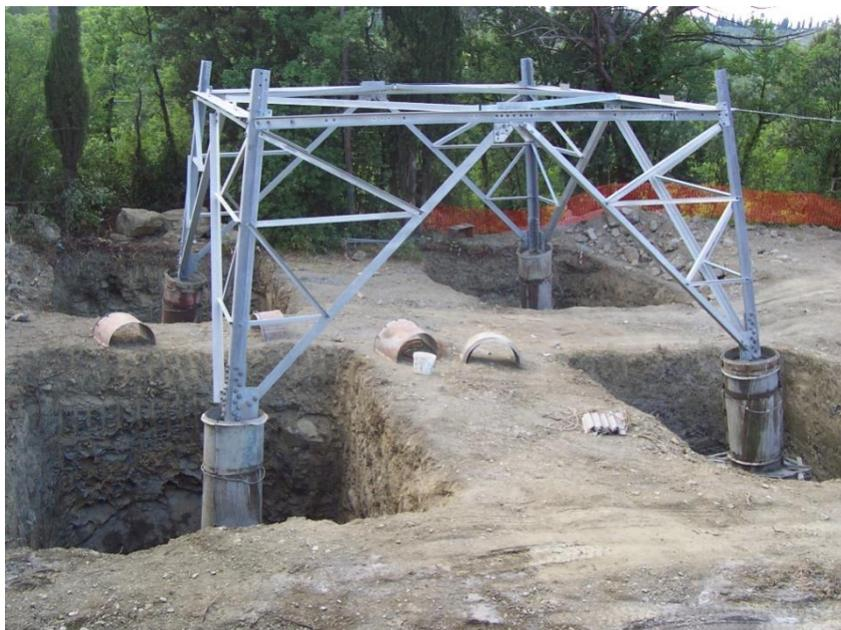
**Figura 2.12.1.1-1: Esempio di fondazione di un sostegno**
