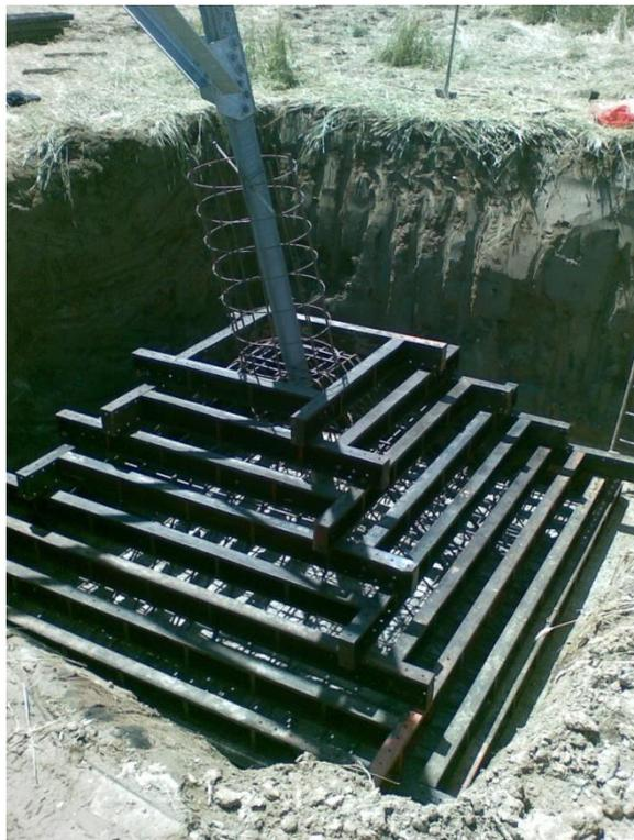
**Figura 2.12.1.1-2: Esempio di realizzazione del piede di fondazione**
