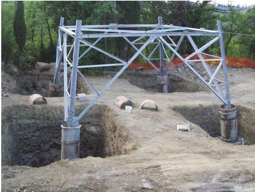
**Figura 4.10.1.1-1: Esempio di fondazione di un sostegno**
