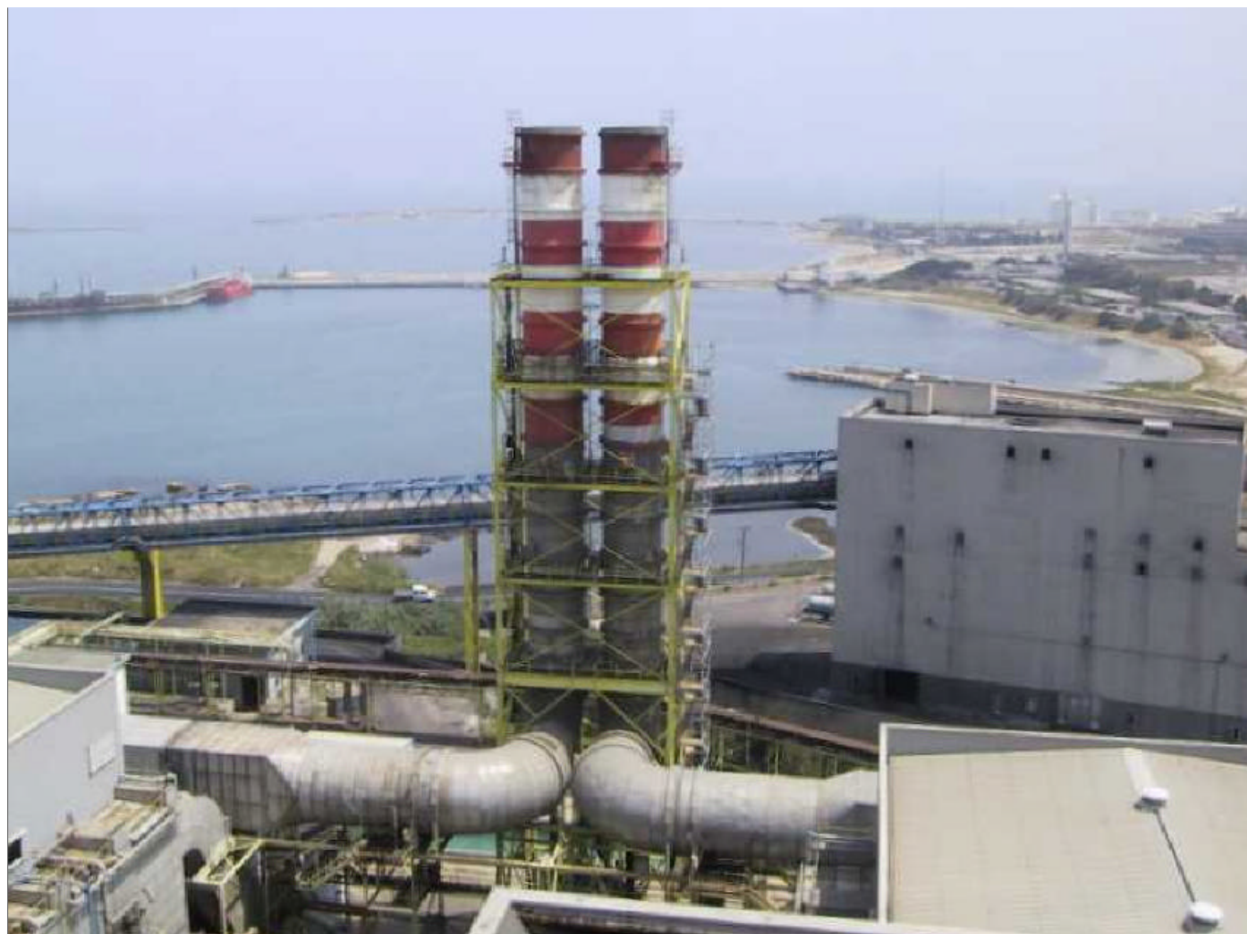
FOTO 1: I camini dei gruppi 3 e 4 ripresi dagli edifici caldaie. Alle loro spalle si scorge il nastro per il trasporto carbone e, sulla destra, la torre carbone T4
