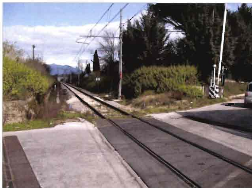
Foto - P.L. al km 143+833
