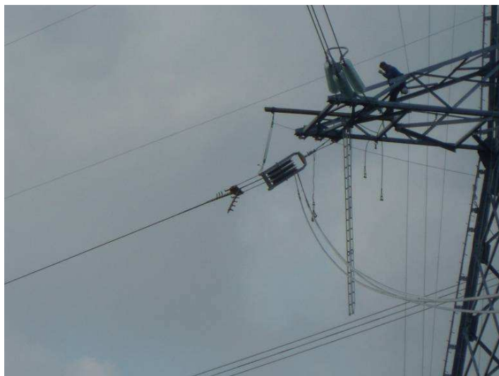
Fasi di tesatura della linea elettrica
