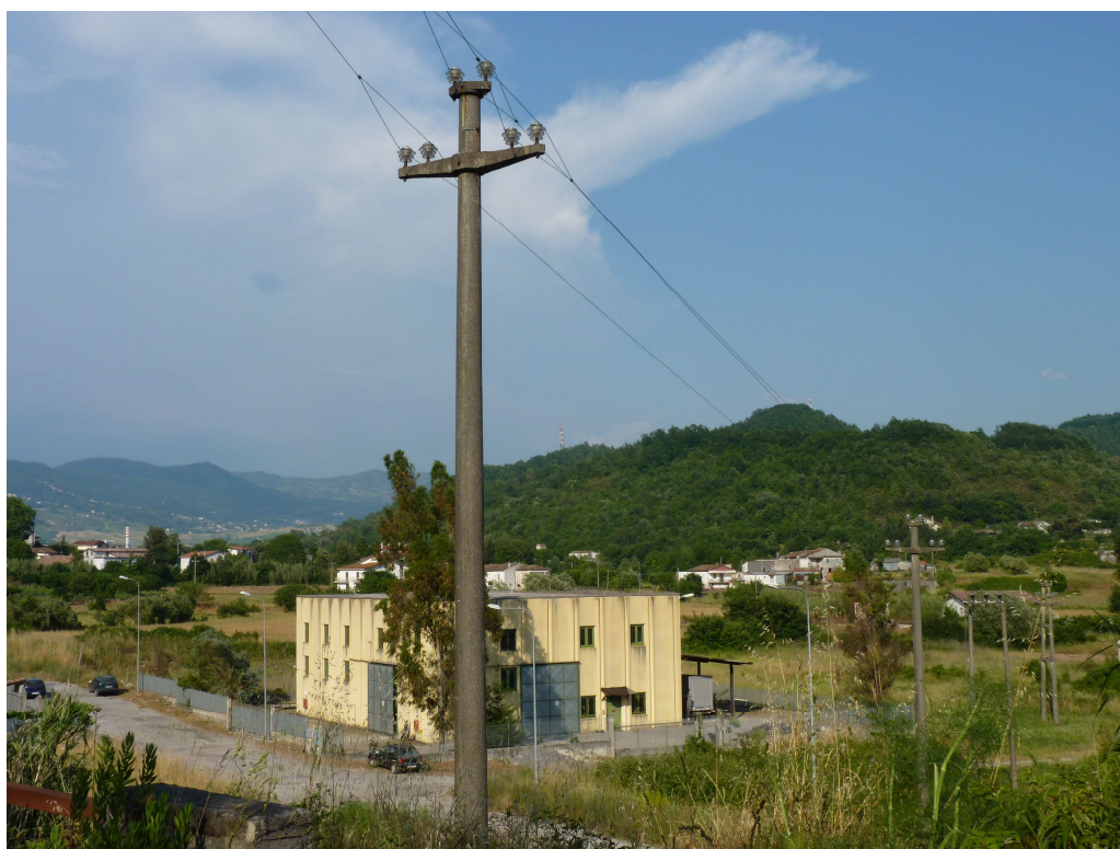
Figura 4.2.1-3 Linee MT da sostituire con elicord (Comune di Laino Borgo – Linea MT zona PIP Laino Borgo)
