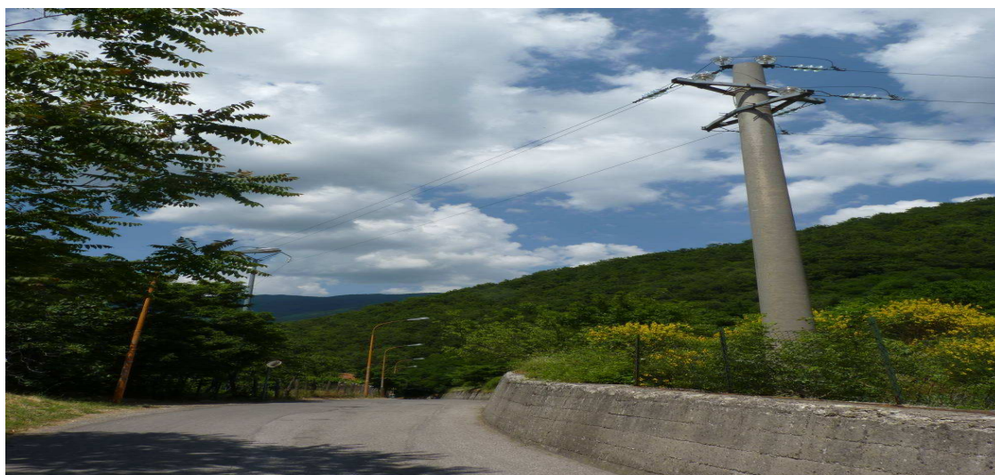
Figura 4.2.1-5 Linee in MT da sostituire con elicord (Comune di S. Lorenzo Bellizzi)
