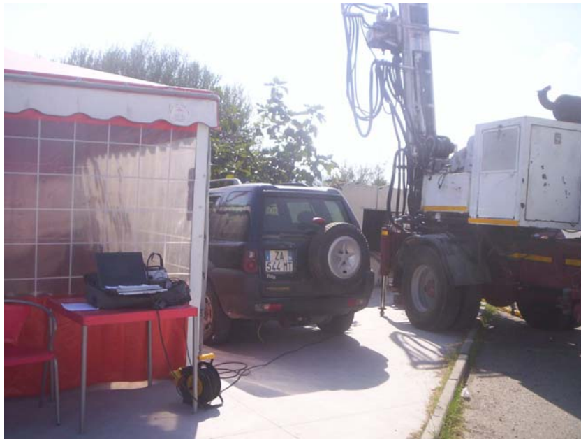
Fig.3) Misurazioni e stazione PC – Pozzo6
