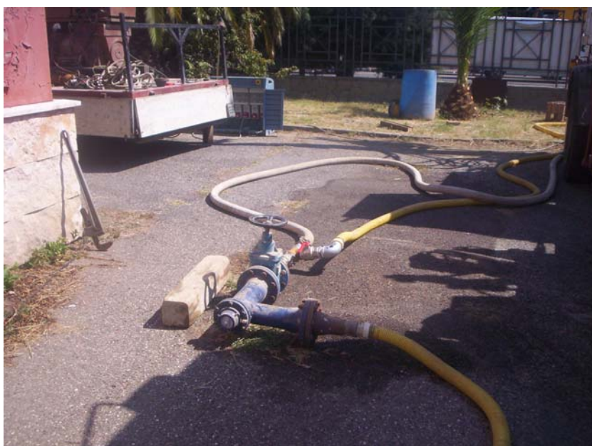
Fig.5) Particolare Contalitri tarato – Pozzo5
