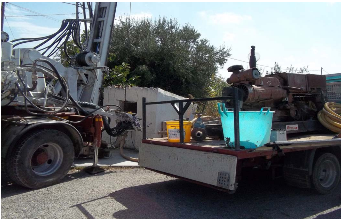
TEST IDRAULICO POZZO P6 (acquisizione dati)
