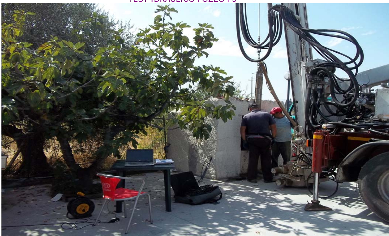
TEST IDRAULICO POZZO P6 (installazione strumentazione ed acquirente dati)
