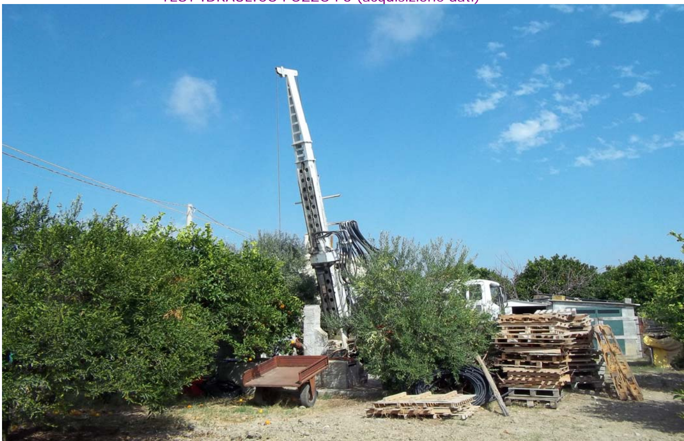
TEST IDRAULICO POZZO P7
