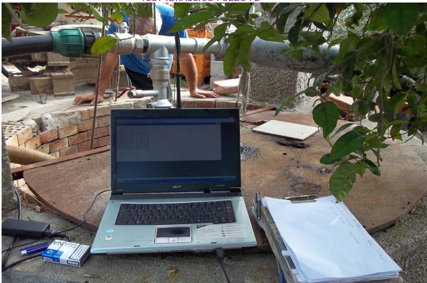
TEST IDRAULICO POZZO P2 (acquisizione dati)
