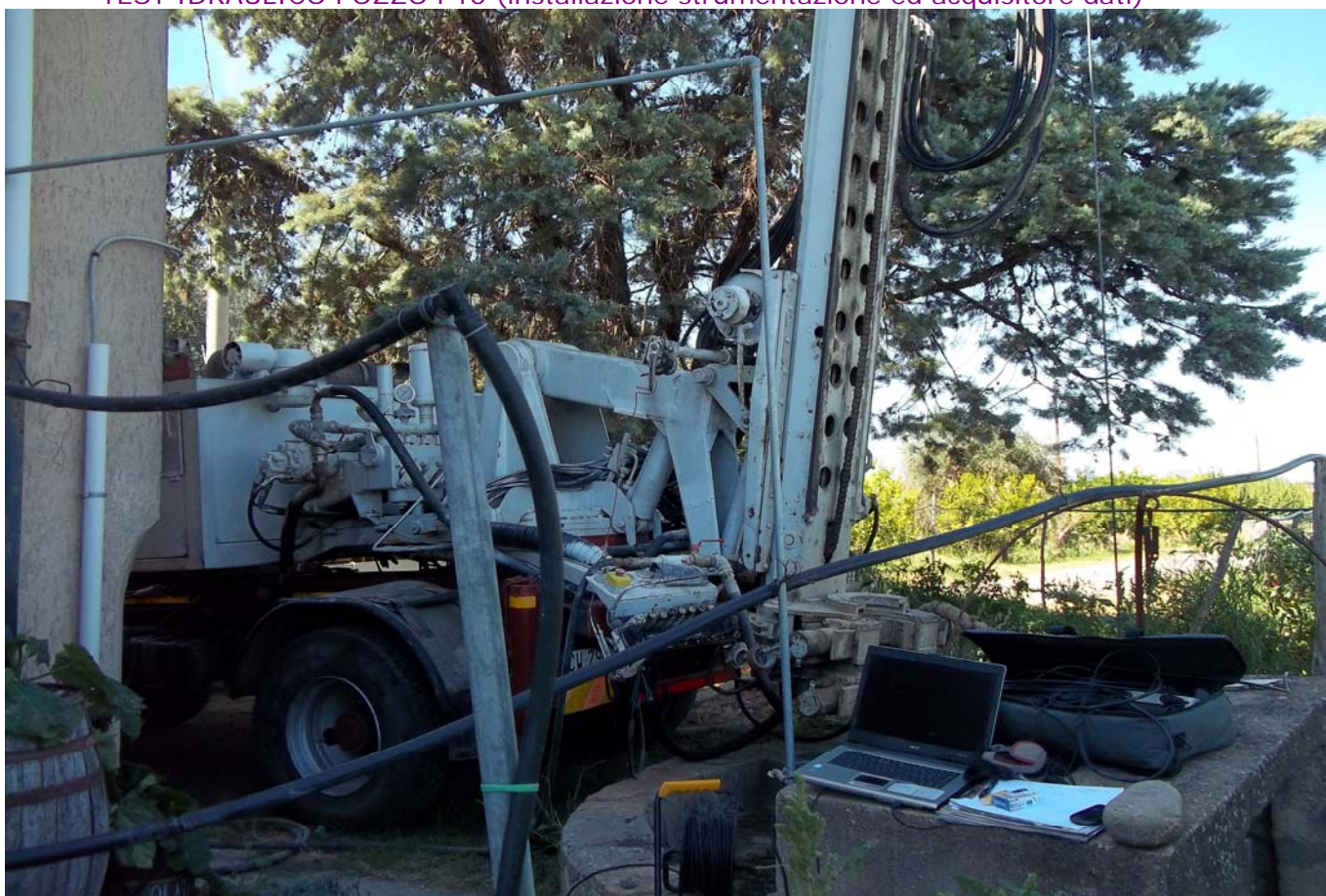
TEST IDRAULICO POZZO P10
