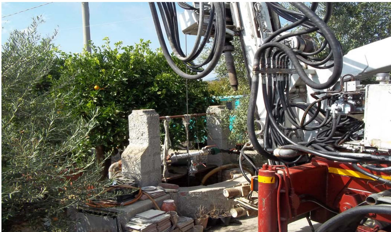
TEST IDRAULICO POZZO P2
