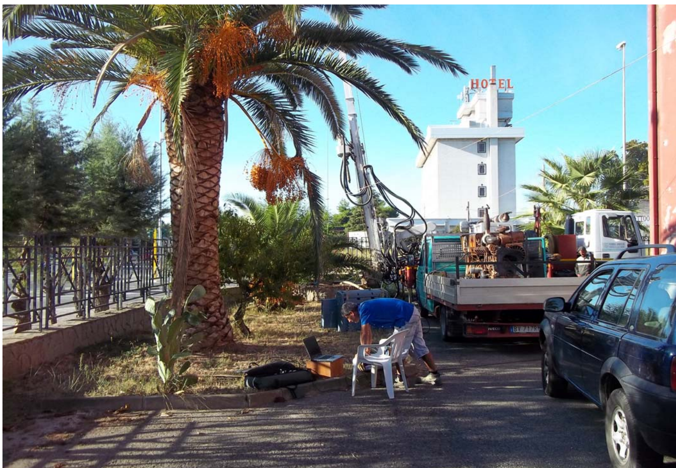
TEST IDRAULICO POZZO P5
