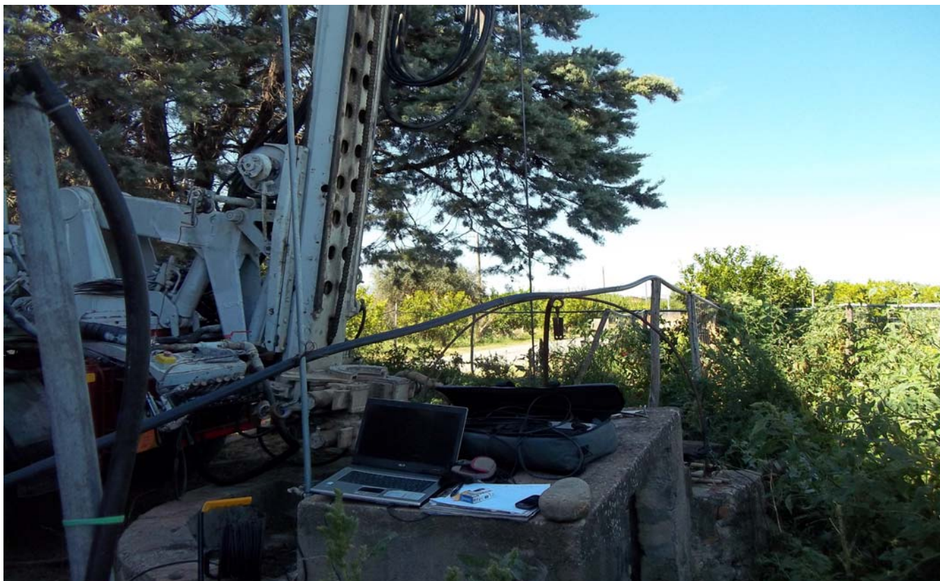
TEST IDRAULICO POZZO P10 (installazione strumentazione ed acquirente dati)
