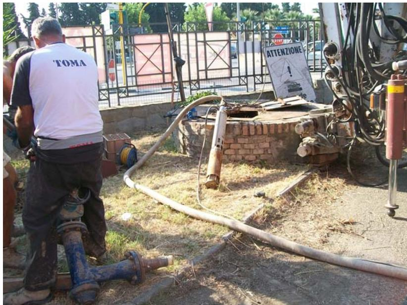
Fig.2) Particolare Pompa Caprari serie E4XP con motore LOWARA serie 4OS – Pozzo5
