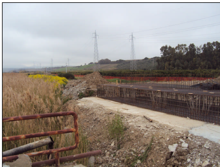
3.1 – Cantiere nei pressi del Torrente Toccaciolo
