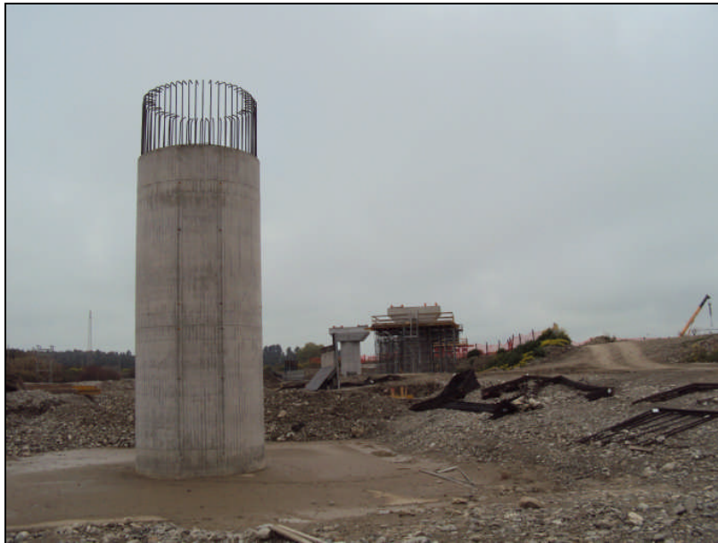
Foto n. 10 – Area di cantiere
