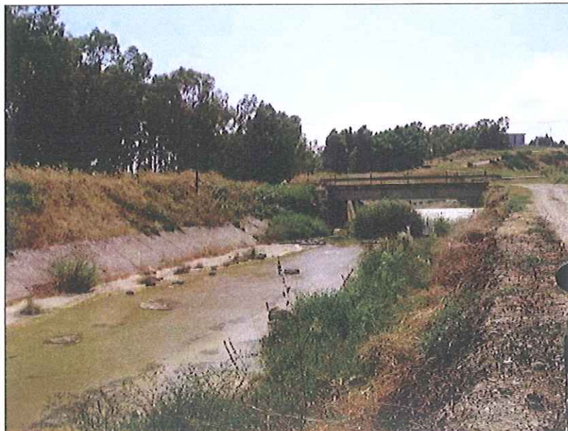
Foto 1 – Torrente Pantanello nella stazione di monte ST_3 (Fonte: Laserlab, 2012)
