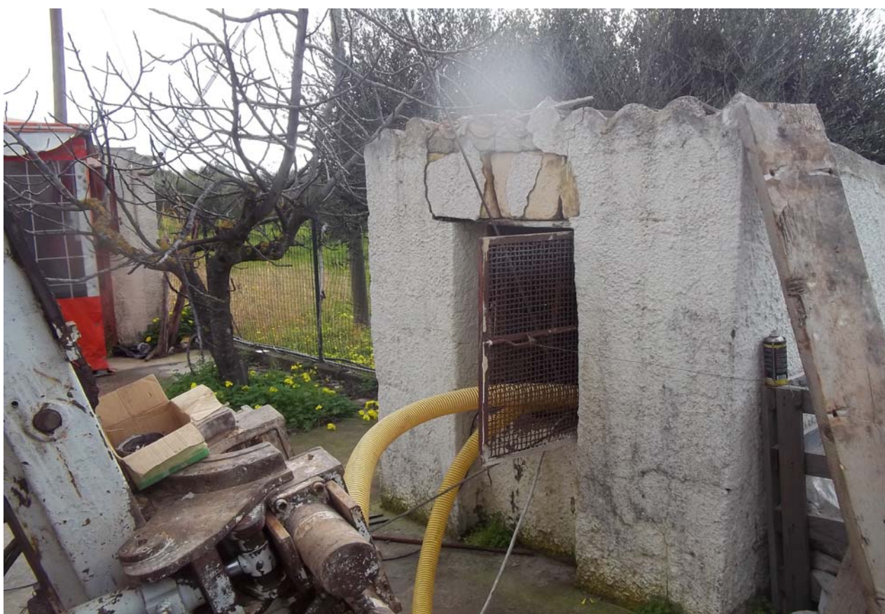
TEST IDRAULICO POZZO P6
