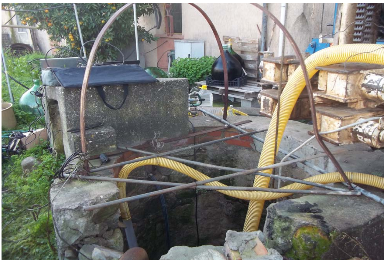
TEST IDRAULICO POZZO P10 (particolare tubazione)
