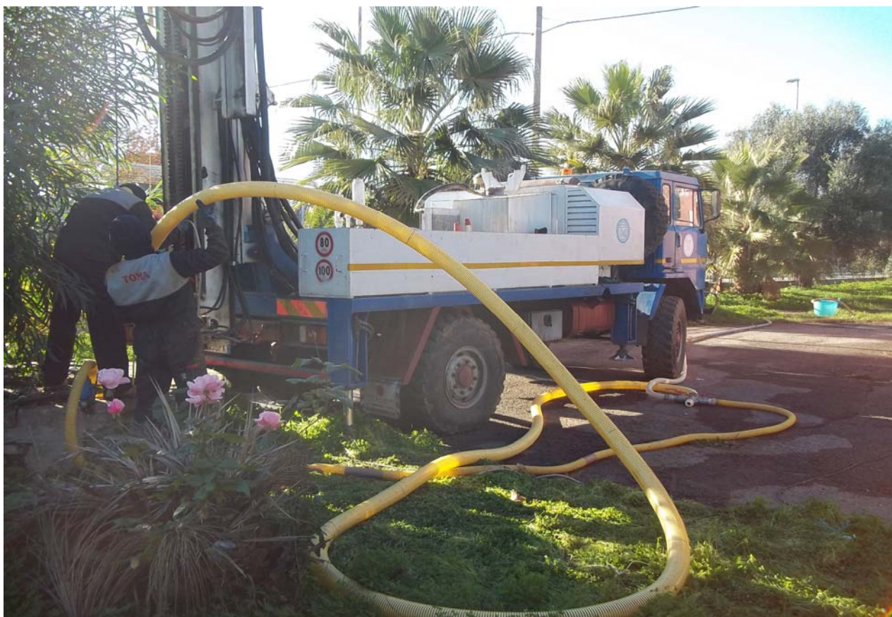
TEST IDRAULICO POZZO P5 (installazione tubazioni e scarico)
