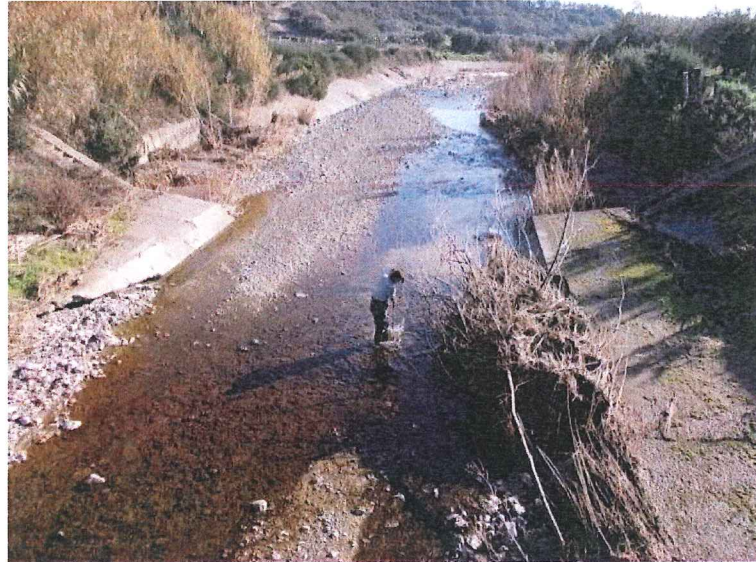
Foto 3.1 – Particolare del T. Toccaciolo nella stazione di monte ST_1
