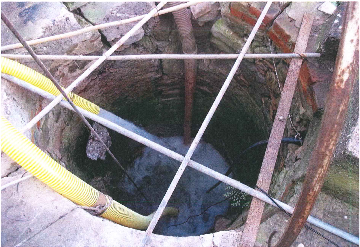
TEST IDRAULICO POZZO P10 (particolare)
