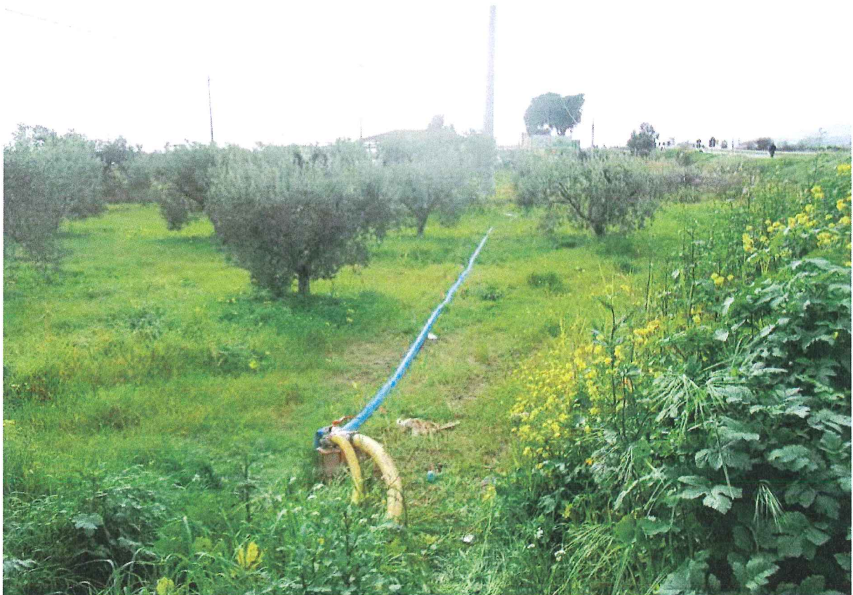
TEST IDRAULICO POZZO P6 (tubazione di scarico)
