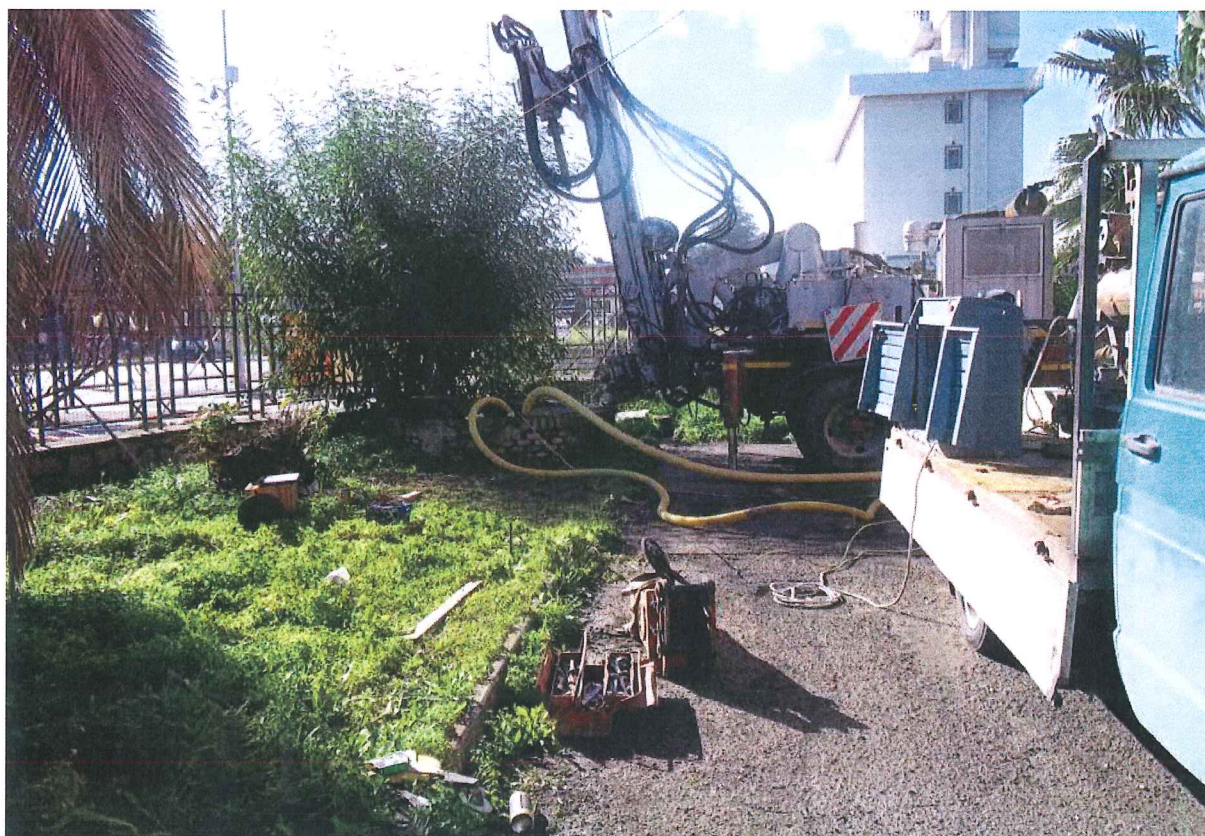
TEST IDRAULICO POZZO P5
