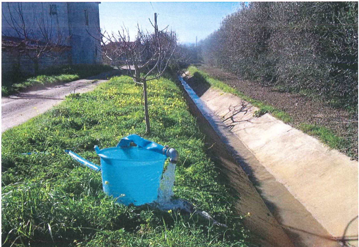
TEST IDRAULICO POZZO P2 (tubazione di scarico)
