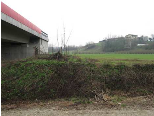
Agli estremi il viadotto e la cascina dello Spià
