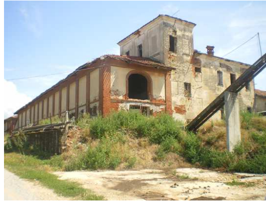
Vista laterale NW e posteriore della cascina
