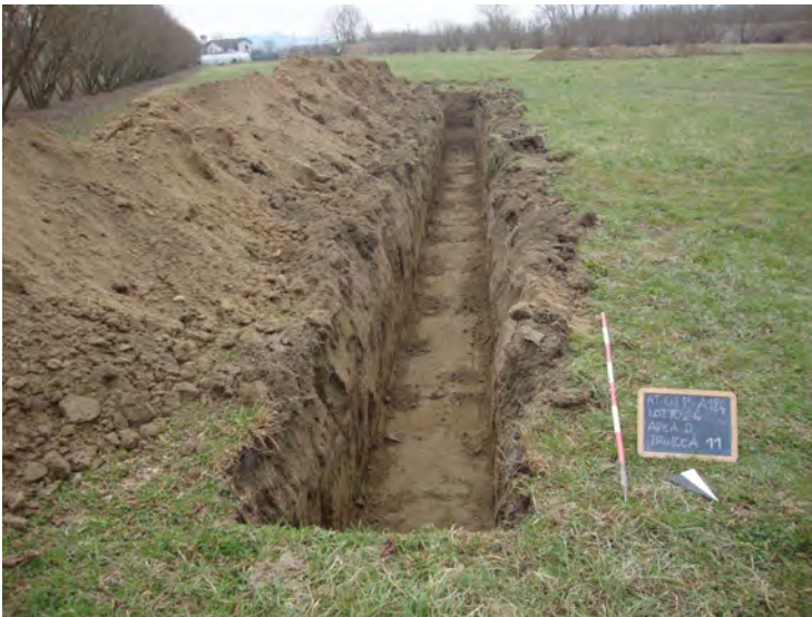
Trincea 11: panoramica da nord-est
