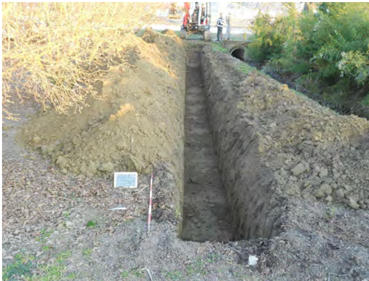
Trincea 20: panoramica da ovest
