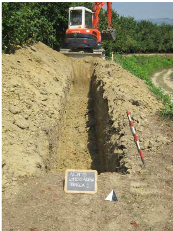
Trincea 1: panoramica da sud
