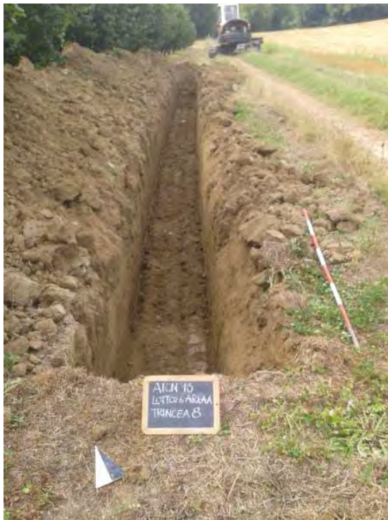
Trincea 8: panoramica da sud
