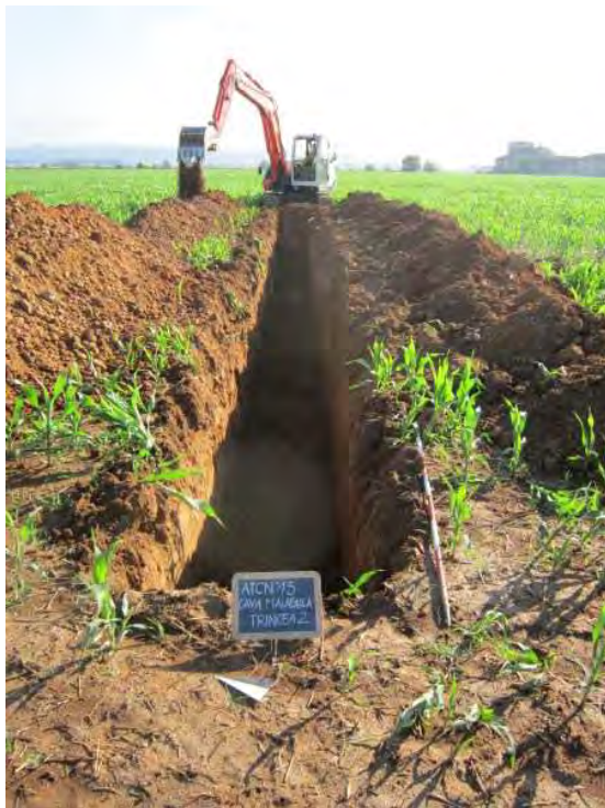
Trincea 2: panoramica da sud-est
