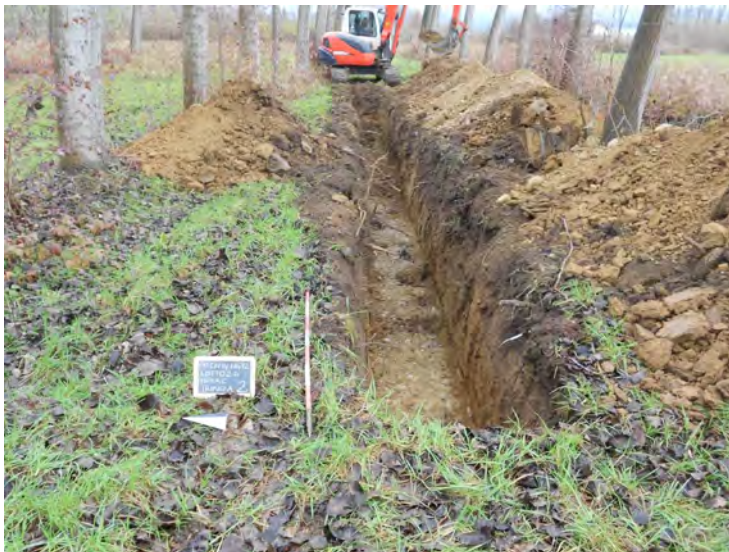
Trincea 2: panoramica da ovest
