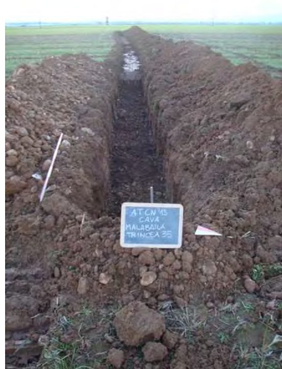
Trincea 35: panoramica da nord est
