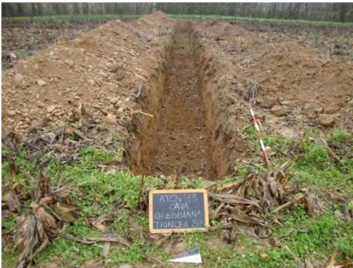
Trincea 37: panoramica da ovest
