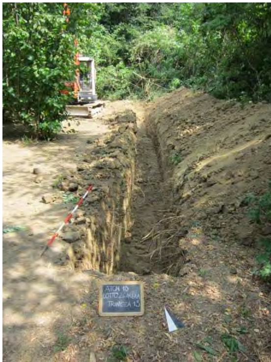
Trincea 13: panoramica da sud
