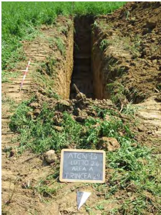
Trincea 29: panoramica da sud
