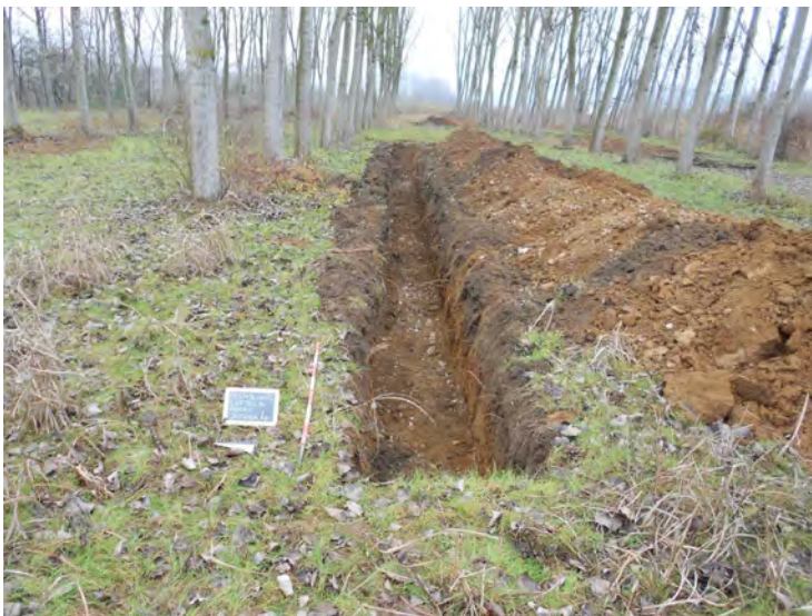
Trincea 4: panoramica da ovest
