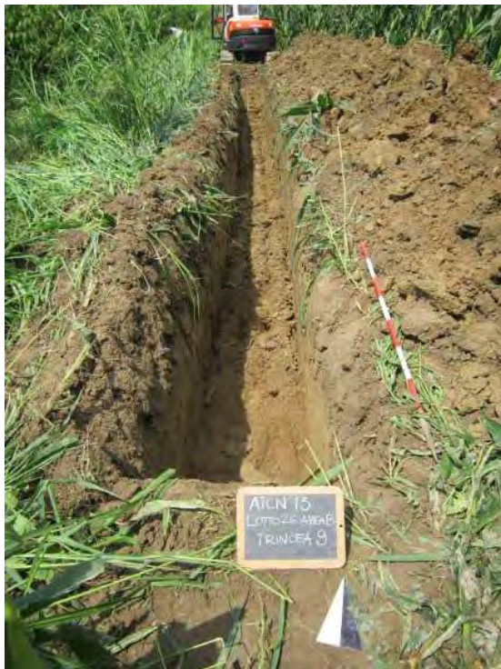
Trincea 9: Panoramica da sud
