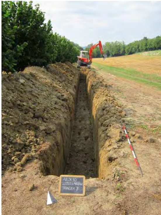
Trincea 7: panoramica da sud
