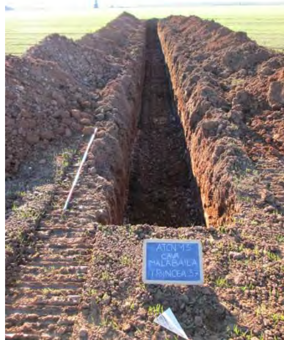
Trincea 37: panoramica da nord est
