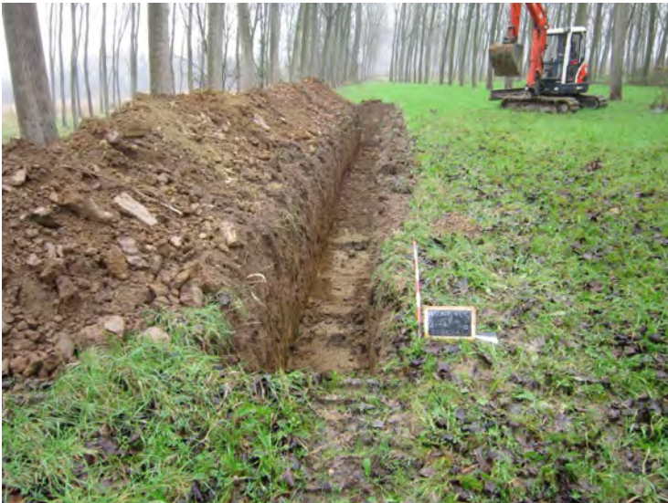
Trincea 8: panoramica da ovest
