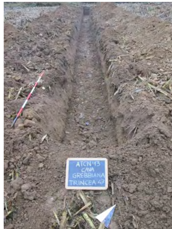
Trincea 47: panoramica da sud est
