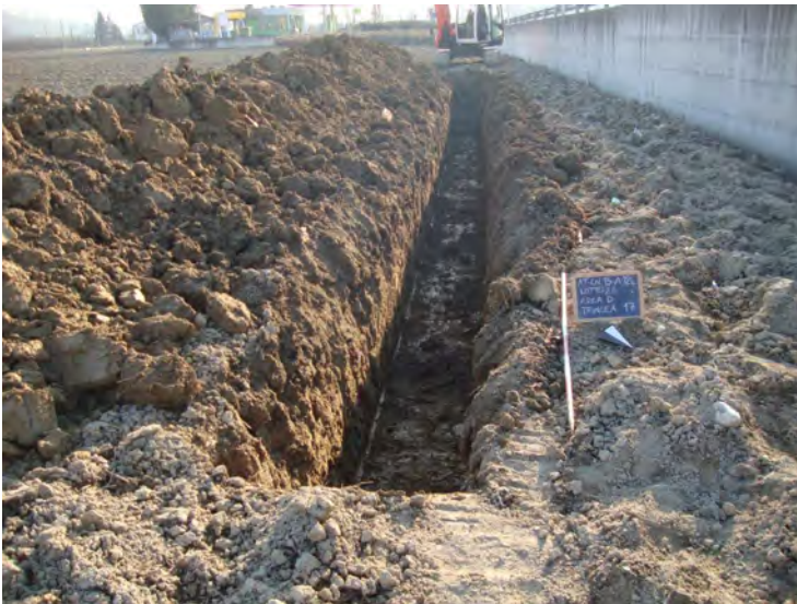
Trincea 17: panoramica da nord-est
