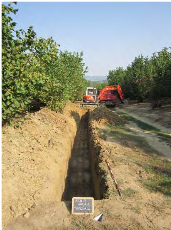
Trincea 2: panoramica da sud-est
