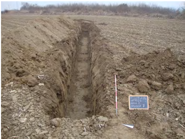
Trincea 7: panoramica da ovest
