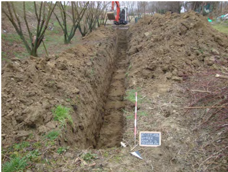
Trincea 24: panoramica da nord-est
