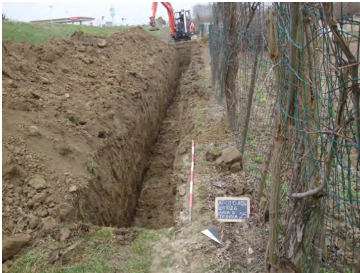
Trincea 25: panoramica da nord-est
