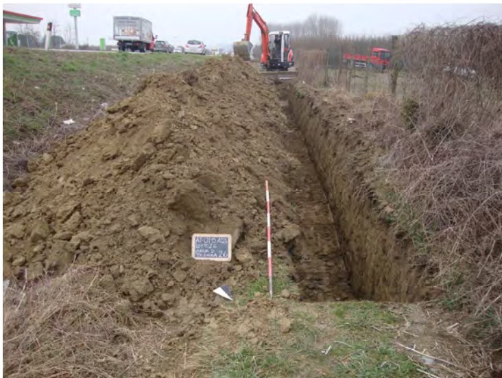
Trincea 26: panoramica da nord-est
