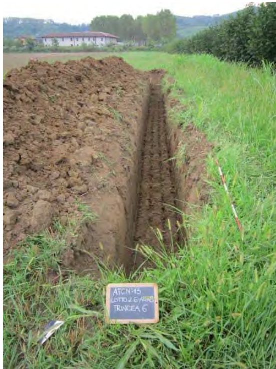
Trincea 6: panoramica da sud
