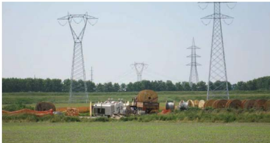
Figura 4.6 - Esempio di cantiere di linea per la tesatura dei conduttori
