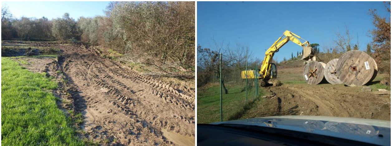
Figura 4.7 - pista di accesso ai microcantieri dei nuovi tralicci (sx) e trasporto dei conduttori tramite piste temporanee (dx)
