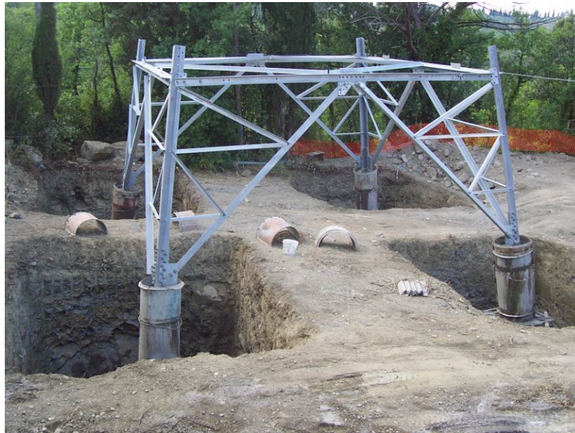
Figura 4.1 - Esempio di fondazione di un sostegno
