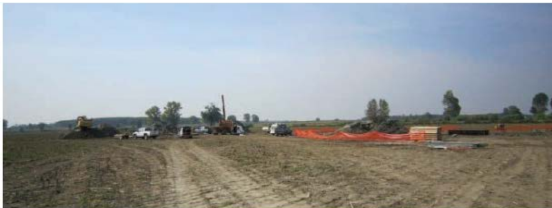
Figura 4.4 - Esempio di micro cantiere con annessa pista di accesso
