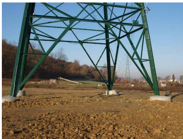
Figura 6.1 - Ricostituzione suolo agrario sulla superficie dismessa di un microcantiere
