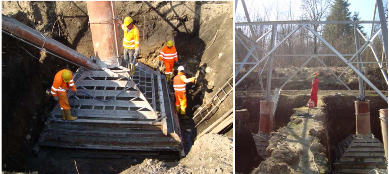
Figura 4.2 - Esempio di realizzazione del piede di fondazione
