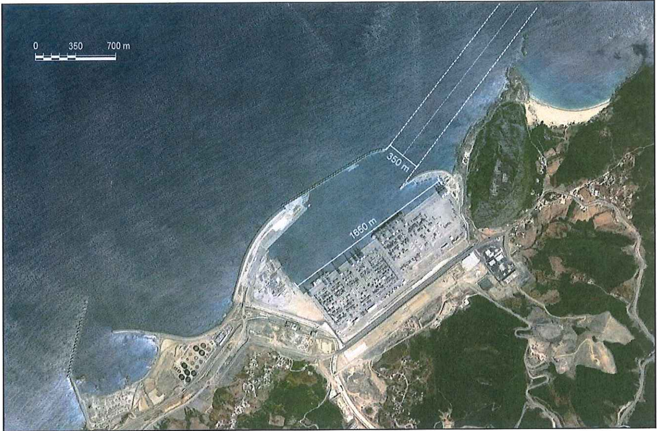
Figura 7. Nuovo porto per contenitori di Tangerang
