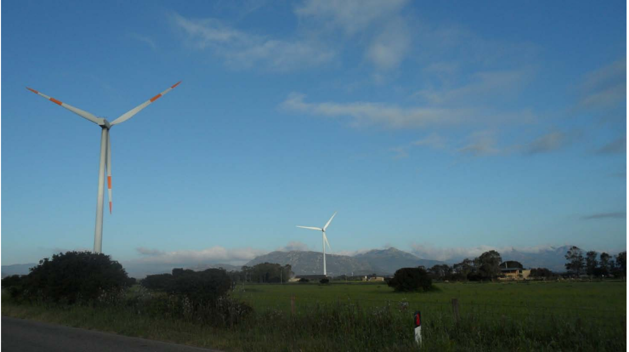
Veduta panoramica dell'area prevista per il passaggio del cavidotto che dall'area dall'impianto CSP deve attraversare quasi 10 Km. di zona agricola prima di arrivare all'Area Industriale di Villacidro.
