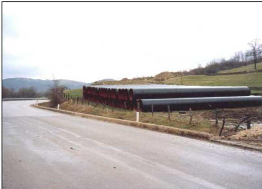
**Figura 3-25: area stoccaggio tubazioni (Fonte: Specifica per posa condotte, eni)**
