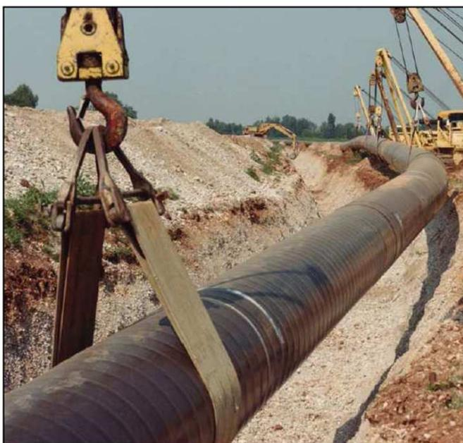
**Figura 3-31: esempio di posa di condotta (Fonte: Specifica per posa condotte, Allegato 4 – eni)**
