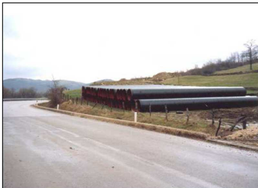
Figura 4-14: area stoccaggio tubazioni (Fonte: Specifica per posa condotte, eni)
