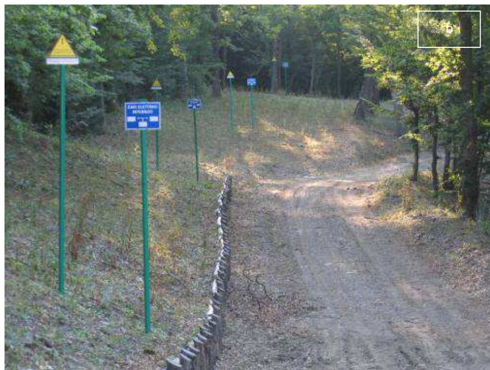
Figura 4-22: Esempi di aree ripristinate (a) e (b), dopo la posa delle condotte
