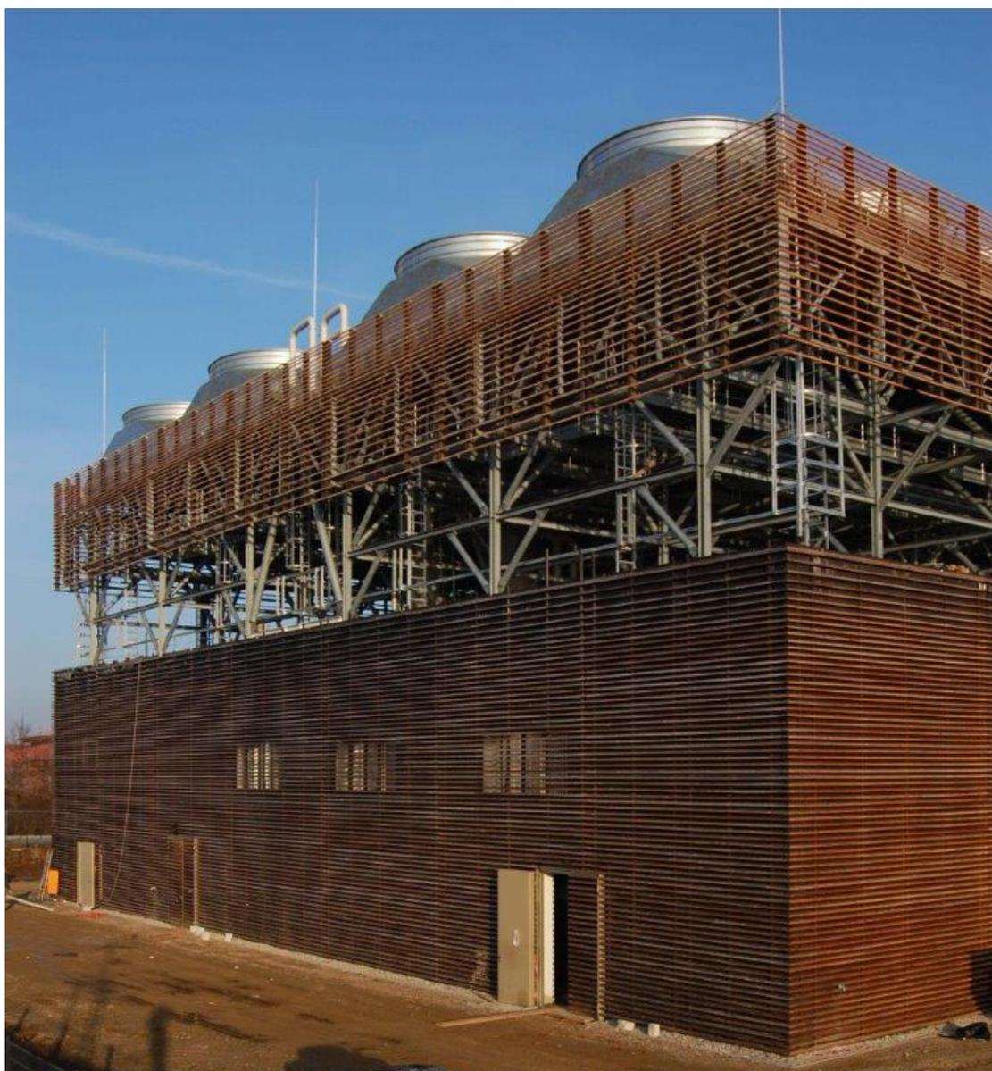
**Figura 2-4 Centrale geotermoelettrica ORC di Sauerlach (Germania)**
