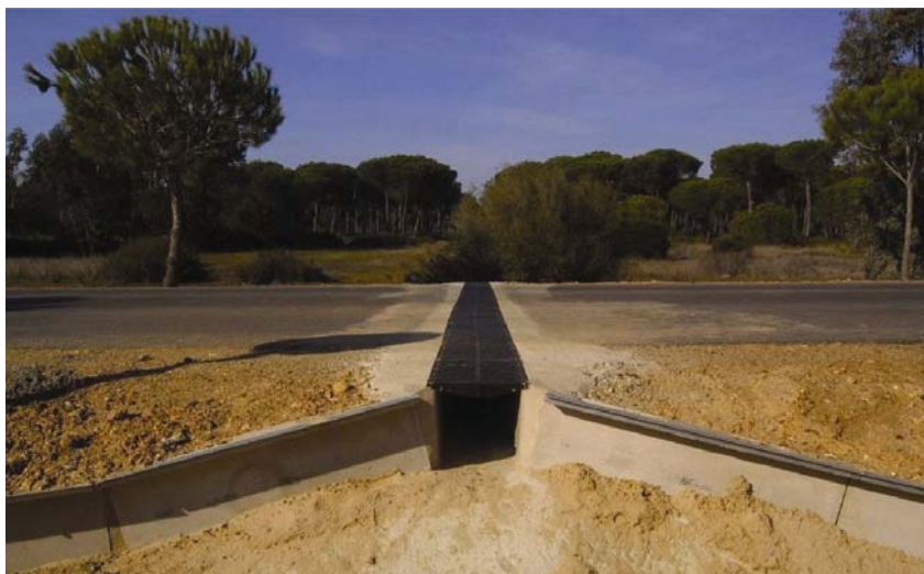
Tunnel per anfibi
