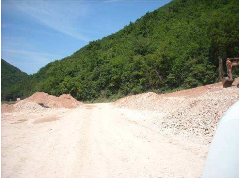
Foto 4: Parte occidentale del cantiere vista est
