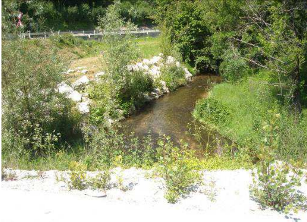
Foto 8 Il fiume Menotre all'ingresso del cantiere
