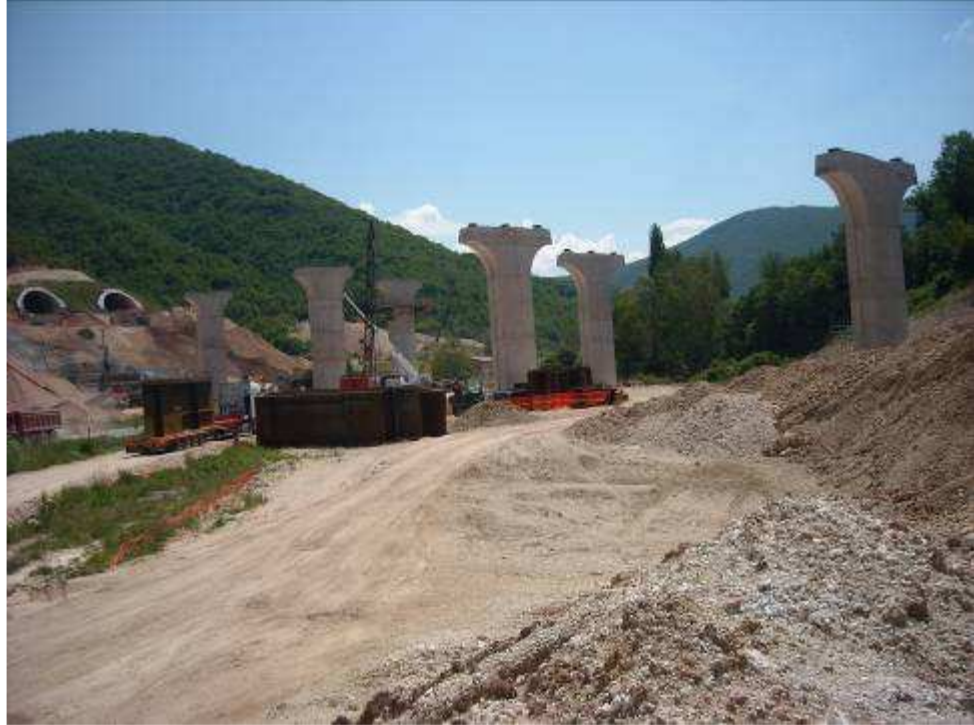
Foto 3: Area di cantiere vista verso Est.
