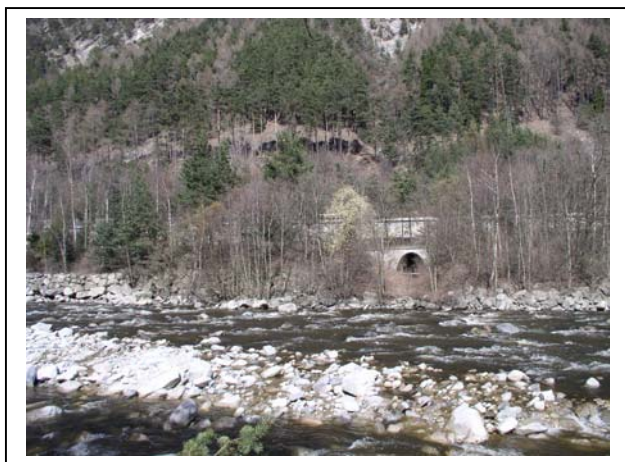
Figura 3: Area di cantiere Fortezza, attacco intermedio, vista sulla sinistra orografica (versante concavo) dell'Isarco. Sullo sfondo la strada statale e l'A22.
