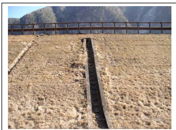
Figura 6: Esempio di un canale di drenaggio (fig. A sinistra) e di conche per l'infiltrazione (fig. a destra ) parallele all'autostrada, dove le acque stradali e i rispettivi agenti inquinanti infiltrano nel suolo.
