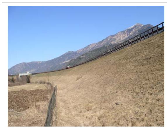
Figura 6: Esempio di un canale di drenaggio (fig. A sinistra) e di conche per l'infiltrazione (fig. a destra ) parallele all'autostrada, dove le acque stradali e i rispettivi agenti inquinanti infiltrano nel suolo.
