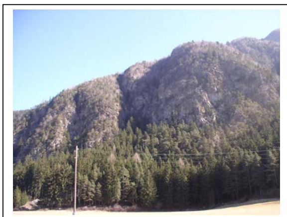
Figura 2 : Area di cantiere presso l'attacco intermedio di Mules, dalla strada statale con vista in direzione est verso l'area di portale; fondovalle piano, depositi di detrito di versante e conoide di debris flow con pendenza moderata, parete rocciosa accliva sullo sfondo.
