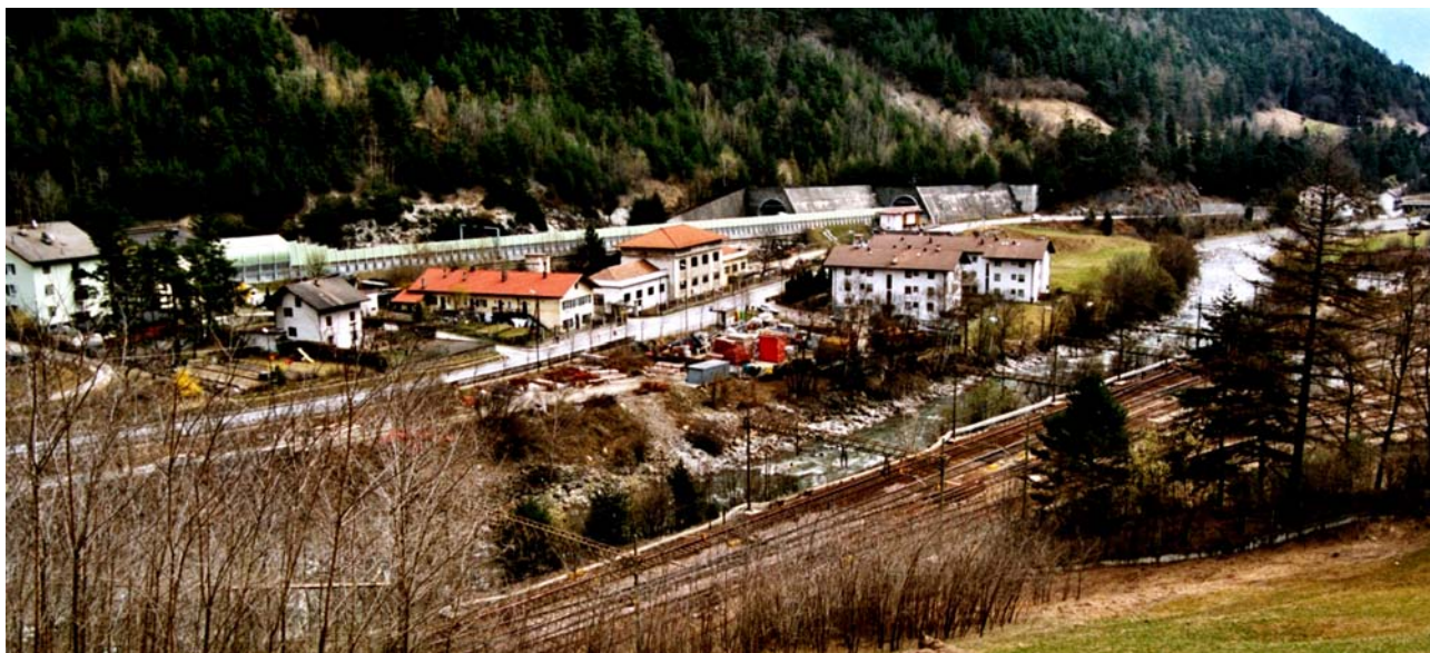
Illustrazione 18: Accesso nord alla località di Fortezza (Foto: RaumUmwelt)
