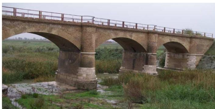
Il fondo alveo, nel tratto identificato dall'ingombro delle pile è rivestito con lastre in pietra e presenta una soglia immediatamente a valle dei sostegni stessi. Le imposta delle pile e delle spalle sono in muratura in pietra
