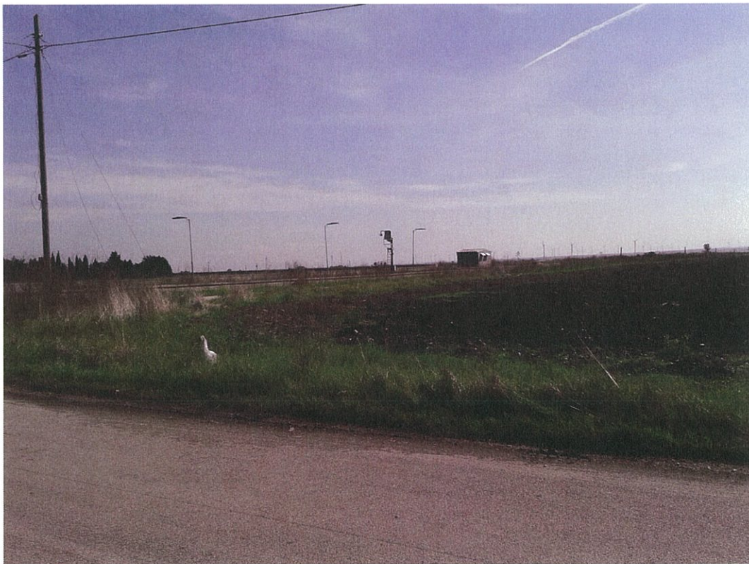
Figura 2. Area della prima trincea di 20 x 5 m.
