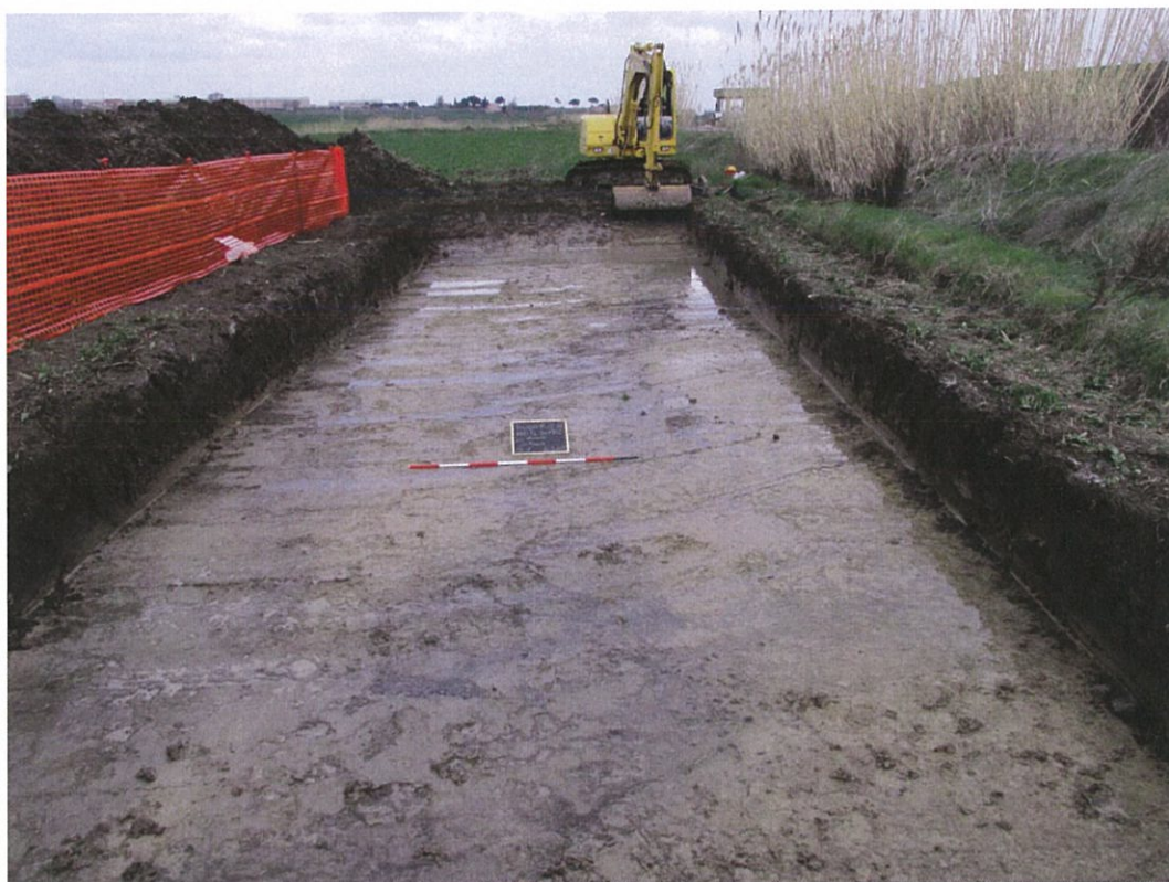
Figura 46 - La trincea 1 al PL 36+782 a fine scavo (profondità 0,80 m)
