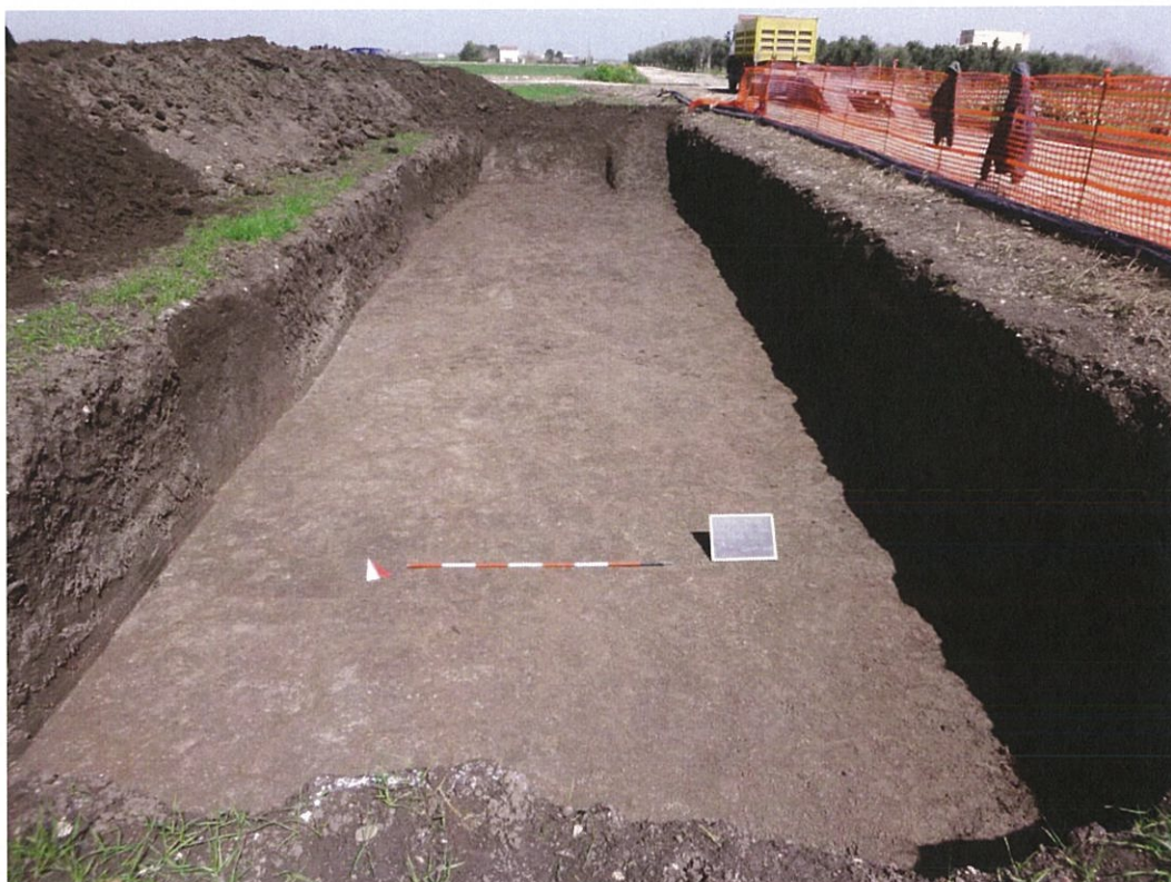
Figura 12 – Trincea 1 in NV02 a fine scavo (profondità m 1,50).
