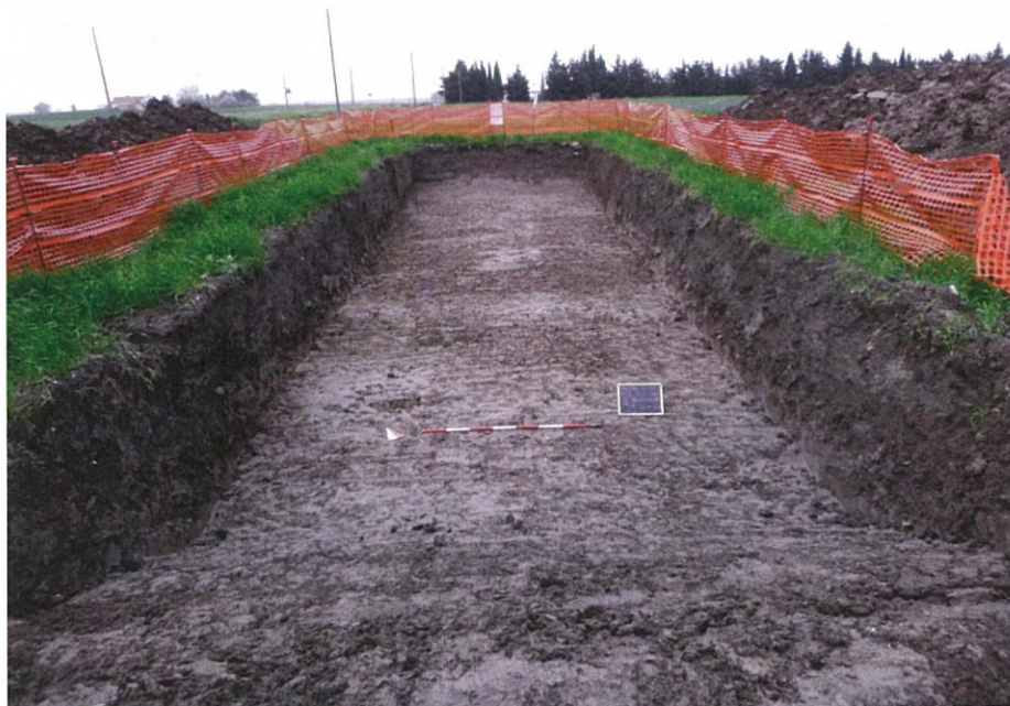
Figura 5 – Trincea 1 in NV01 a fine scavo (profondità m 1,50).
