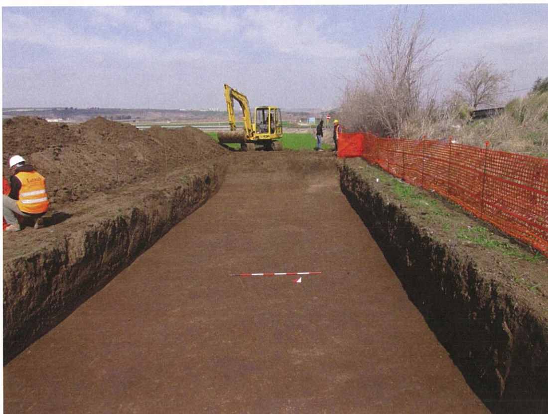
Figura 34 – La trincea 1 in NV05 a fine scavo (profondità 1m)
