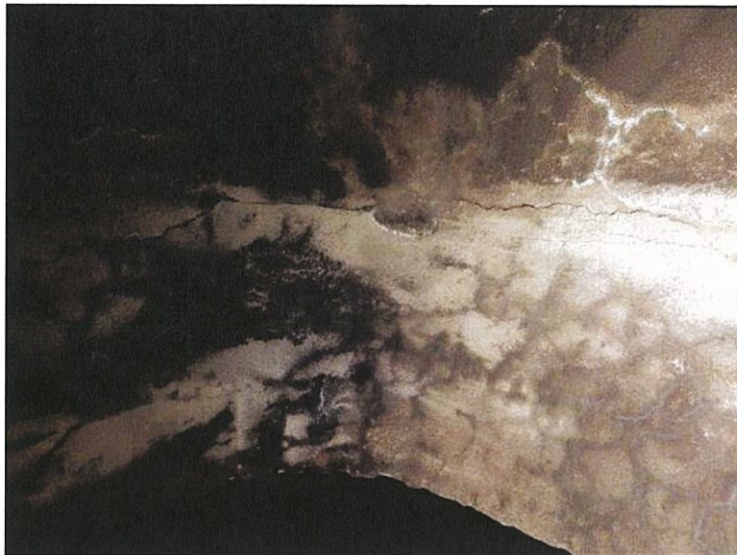
Foto 1 – Lesione in calotta pk rel. 2 m
