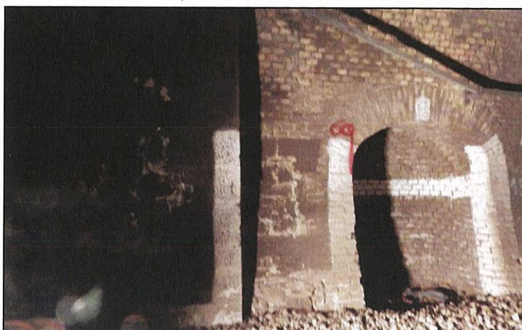
Foto 17. Variazione del profilo d'intradosso pk rel. 59 m
