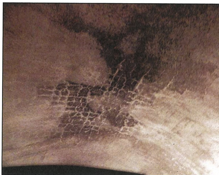
Foto 22. Settore di rivestimento umido (calotta) pk rel. 64 m
