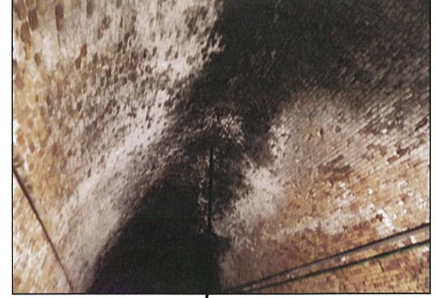
Settore particolarmente umido con venute d'acqua
