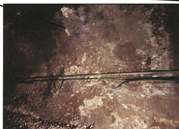
Rivestimento ammalorato
