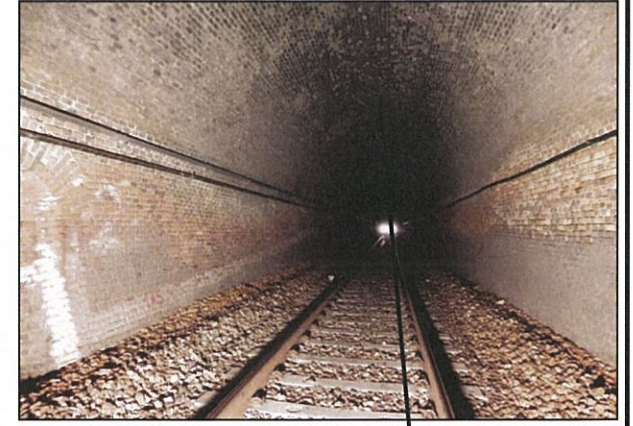
Settore sano del rivestimento
