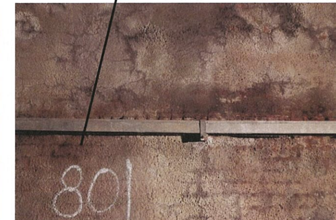
Settori umidissimi con patine rossastre di ossidazione legate all'arrugginimento della rete di armatura
