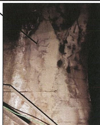
Rivestimento ammalorato
