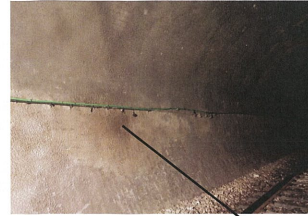
Settore leggermente umido ma in buono stato
