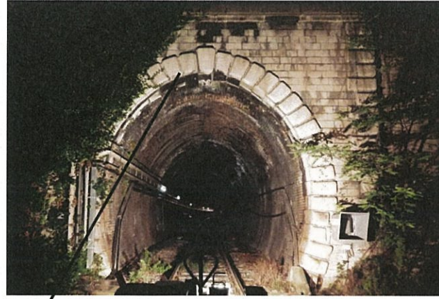
Imbocco galleria lato sud
