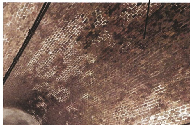
Settore di calotta umido e leggermente ammalarato
