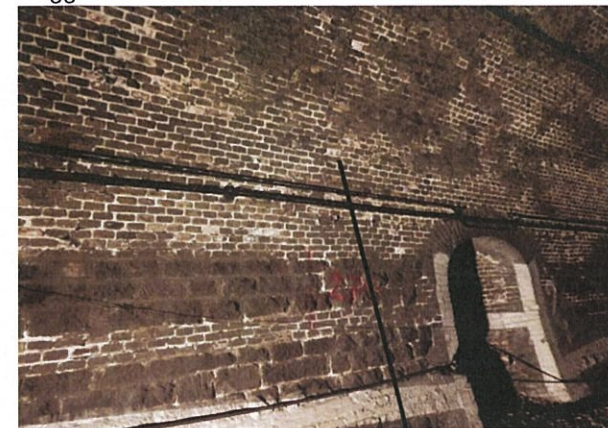
Leggere chiazze di umidità in tratto sano
