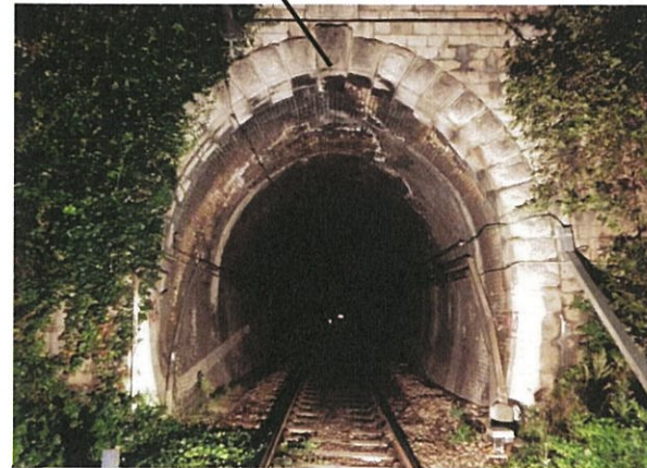
Imbocco galleria lato Potenza Inf.
