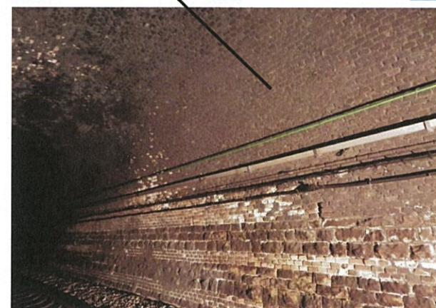
Settore di rivestimento particolarmente sano
