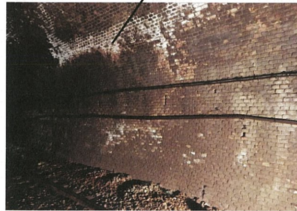
Settore con effluorescenza biancastra e muffa
