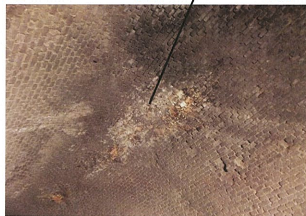
Settore di calotta molto umido con sottilissime e cortissime stalattiti
