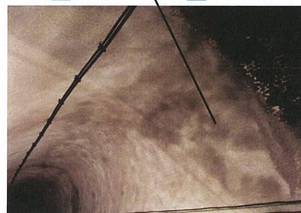
Passaggio nel rivestimento tra mattoni e spritz
