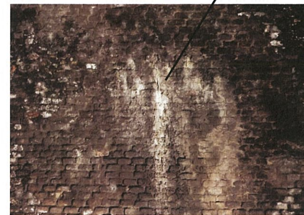
Chiazza di umidità molto evidente con concrezioni carbonatiche
