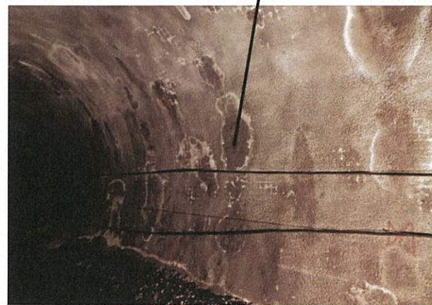
Settore di rivestimento in spritz beton interessato da chiazze di umidità sparse
