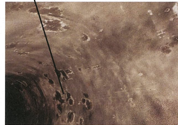
Settore di rivestimento in spritz beton interessato da chiazze di umidità sparse
