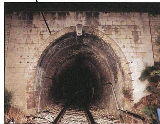
Imbocco della galleria
