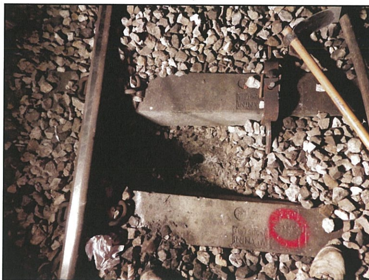
Foto 4. Foro verticale in asse al binario
