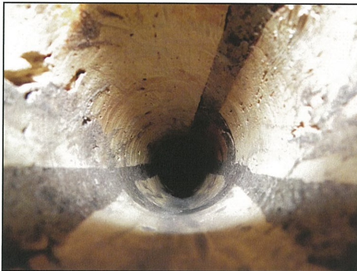
Foto 2. Parete interna di un foro eseguito a carotaggio continuo
