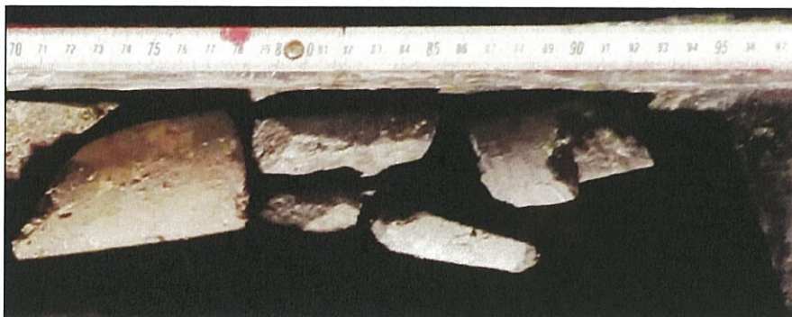
Quattrocchi pk 98+190. Dettaglio contatto rivestimento/substrato
