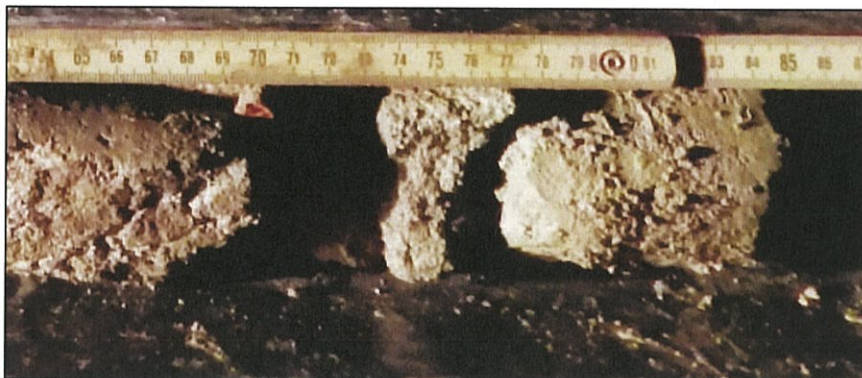
Quattrocchi pk 98+235. Dettaglio contatto rivestimento/substrato
