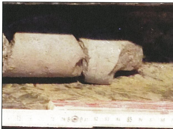
Quattrocchi pk 98+120. Dettaglio contatto rivestimento/substrato
