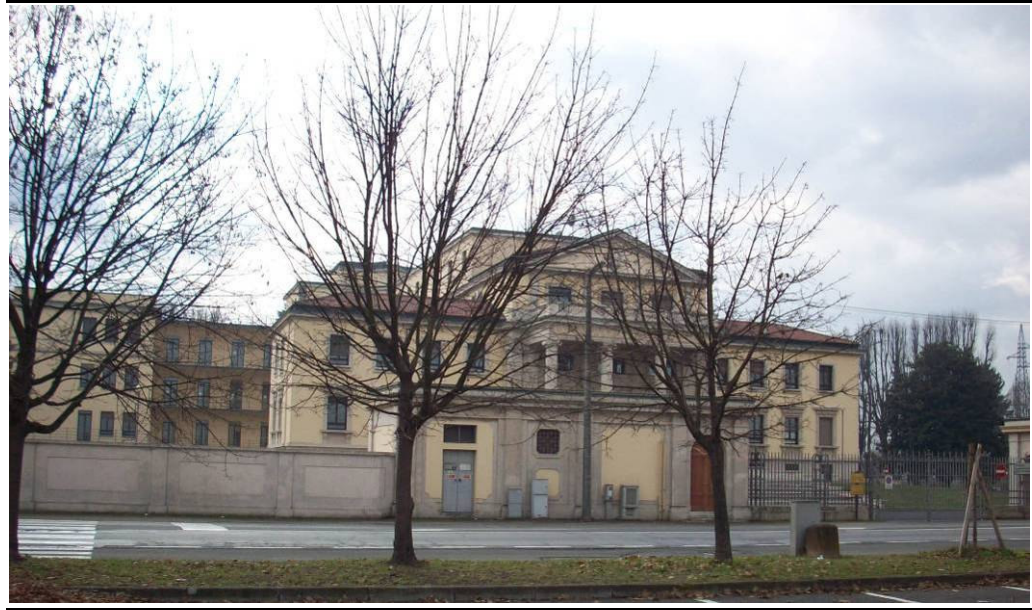
Figura 5.10.5.1b Sede dell'Università, a Nord del Sito di Raffineria
