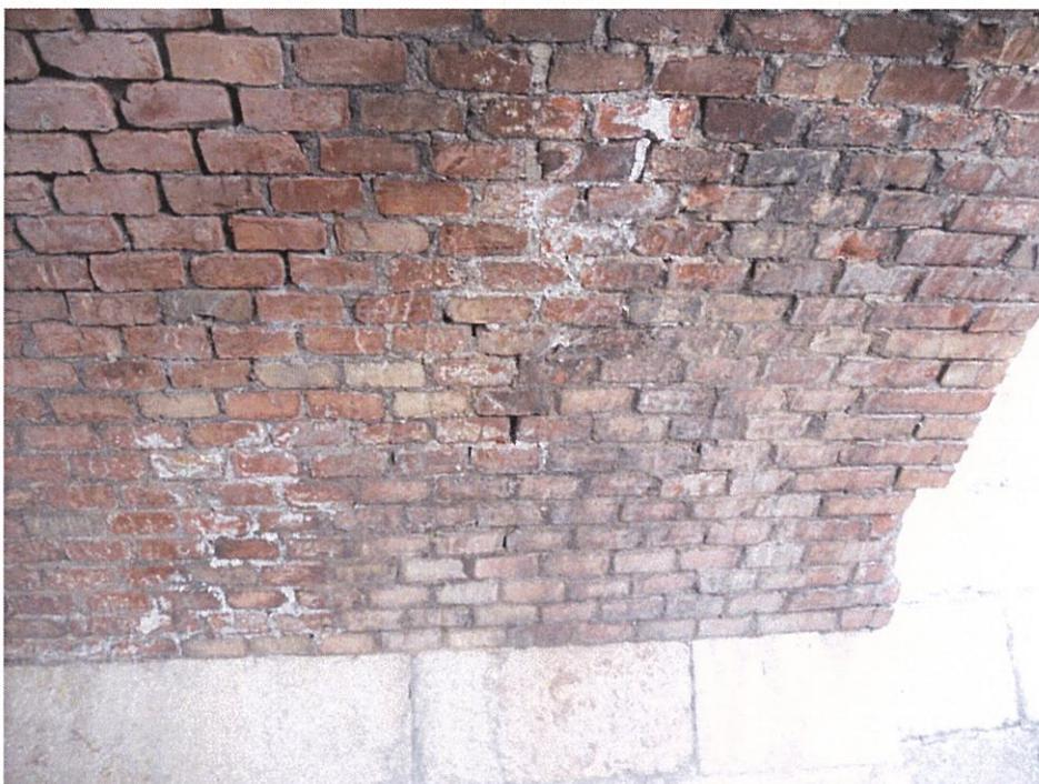
*Tombino sulla tratta Cervaro-Rocchetta alla progressiva 12+005: degrado delle malte nei giunti ed efflorescenze sulla volta*
