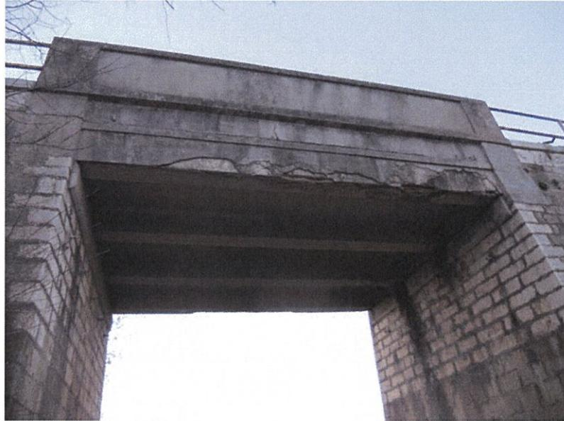
*Sottovia sulla tratta Cervaro -Rocchetta alla progressiva 34+193: distacchi del cls ed esposizione armature sulle travi in c.a.*
