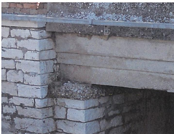
Fig. 3 – Dettaglio del tombino idraulico al km 24+063
